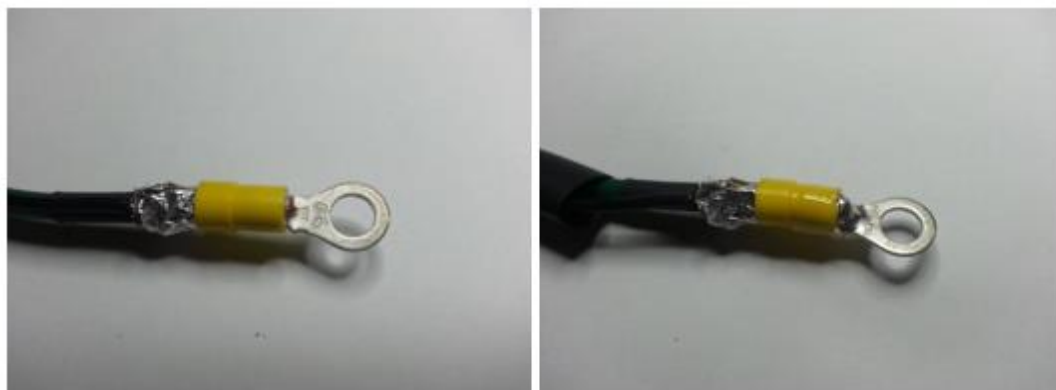
Fig. 8.16: Detalle soldadura de terminación de cable de conexión.
