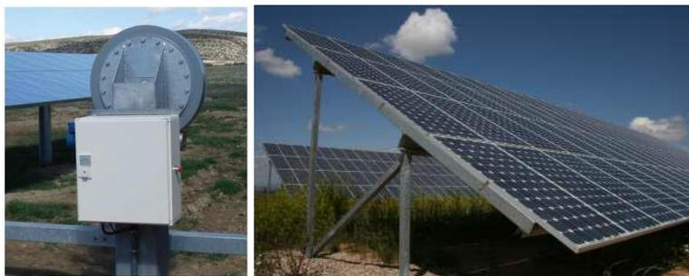
Figura 4.9 Ejemplo de un seguidor solar y el cuadro eléctrico (Fuente: Schneider)
