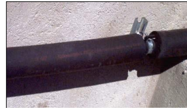
Figura 5.4.p. Aïllament canonada.
