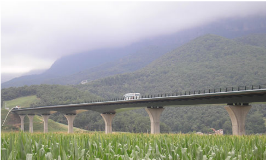
El viaducte del túnel de Bracons situat a la banda de la comarca de la Garrotxa. (Font: http://territori.scot.cat/cat/notices/2009/11/carretera_c_37_vic_olot_pel_tunel_de_bracons_1522.php )
