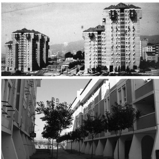
Fig. 11 Uso de los sistemas con encofrado túnel en el polígono Canyelles (Barcelona) y en Constantí (Tarragona). Autoría propia.
