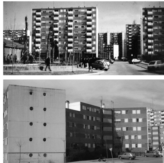
Fig. 8 Bloques lineales altos de 10 a 12 plantas y bloques en estrella de 5 plantas realizados con el Sistema TRACOBA en Ciutat Badia (Barcelona). Imágenes autoría propia.
