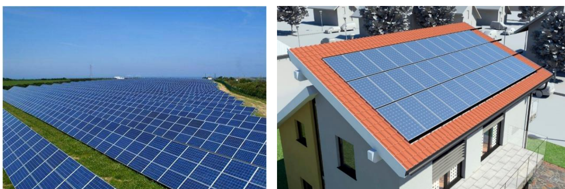
Figura 2 Mostra d'instal·lacions fotovoltaïques connectada a xarxa i aïllada, respectivament.
