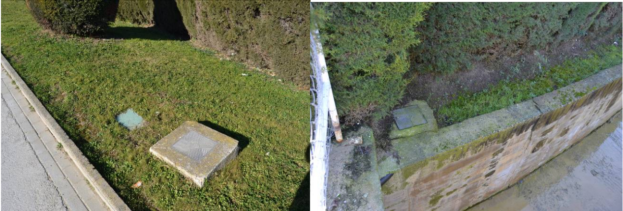
Fotografies 2. Vista de les arquetes i conduccions d'aigua potable identificades
