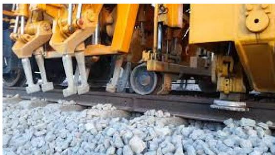
Imagen 1.29: Grupo de bates y pinzas de carril en la parte central de la máquina. Tecsa empresa constructora.
