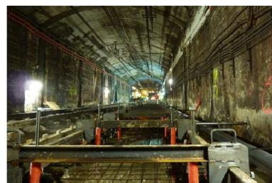
Imagen 1.33: Sujeción DFF. Instalación de vía en placa en avenida Meridiana.
