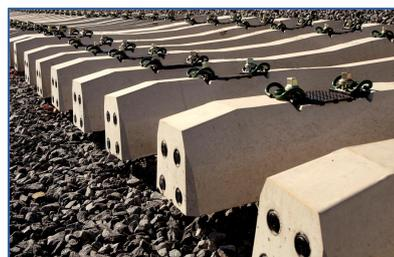
Imagen 1.24: Travesías de madera de roble y travesías de hormigón Monobloc.
