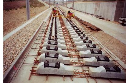
Imagen 1.31: Extendido de traviesas y colocación de carril. Sección constructiva Rheda 2000.
