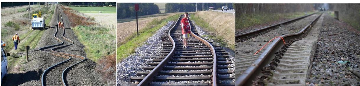
Imagen 1.43: Varios trazados deformados por acción de la dilatación de carril.
