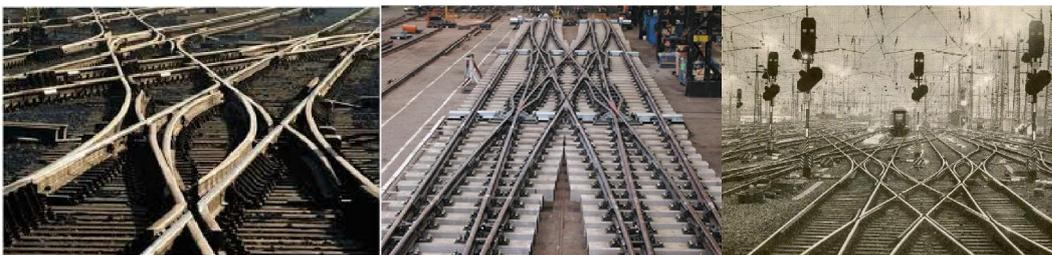
Imagen 1.27: Ejemplos de aparatos de vía. Desvíos simples, dobles, travesías y breteles.
