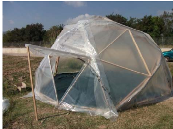
Imatge 1 Fotografia de Francesc García i Blasco (Castelldefels, 2012). Construcció d'un hivernacle geodèsic amb un sistema solar passiu.
