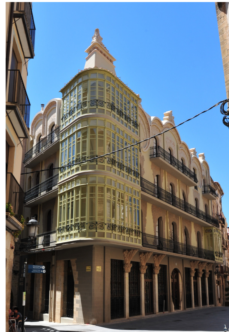
Casa Pilar Fontanet, Tortosa. A d'alt, vista de la façana a la plaça de la Cinta; a l'esquerra, detall del mirador de fusta, vidre i ferro.
