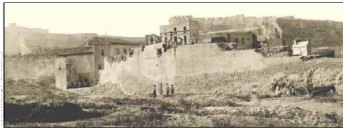
Tortosa 1909. Treballs d'enderrocament de la muralla de Remolins.
