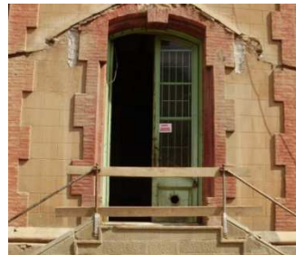
Figura 4.7 Porta d'entrada de la fàbrica d'embotits façana sud-est
