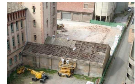
Figura 2.10 Desmantellament de magatzems adjunts a l'edifici
