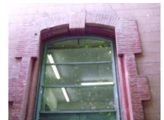
Figura 4.4 Porta convertida en finestra façana nord-est
