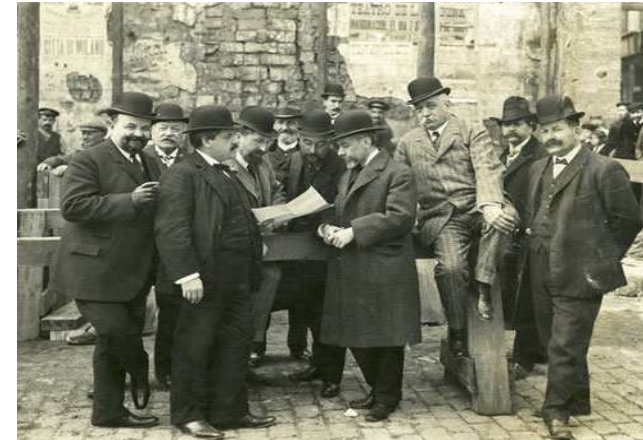
Figura 3.2 Inici d'obres a la Via Laietana amb Sagnier al centre, al costat d'arquitectes com Bonaventura Bassegoda i Pere Falqués
