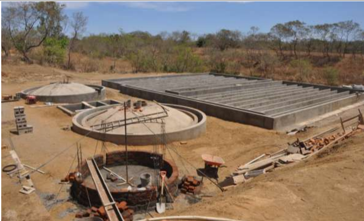
Ilustración 1,2 y 3.- Construcción de canales Jinotega. Pavimentación con concreto hidráulico en El Viejo y Construcción de la PTAR en León.
