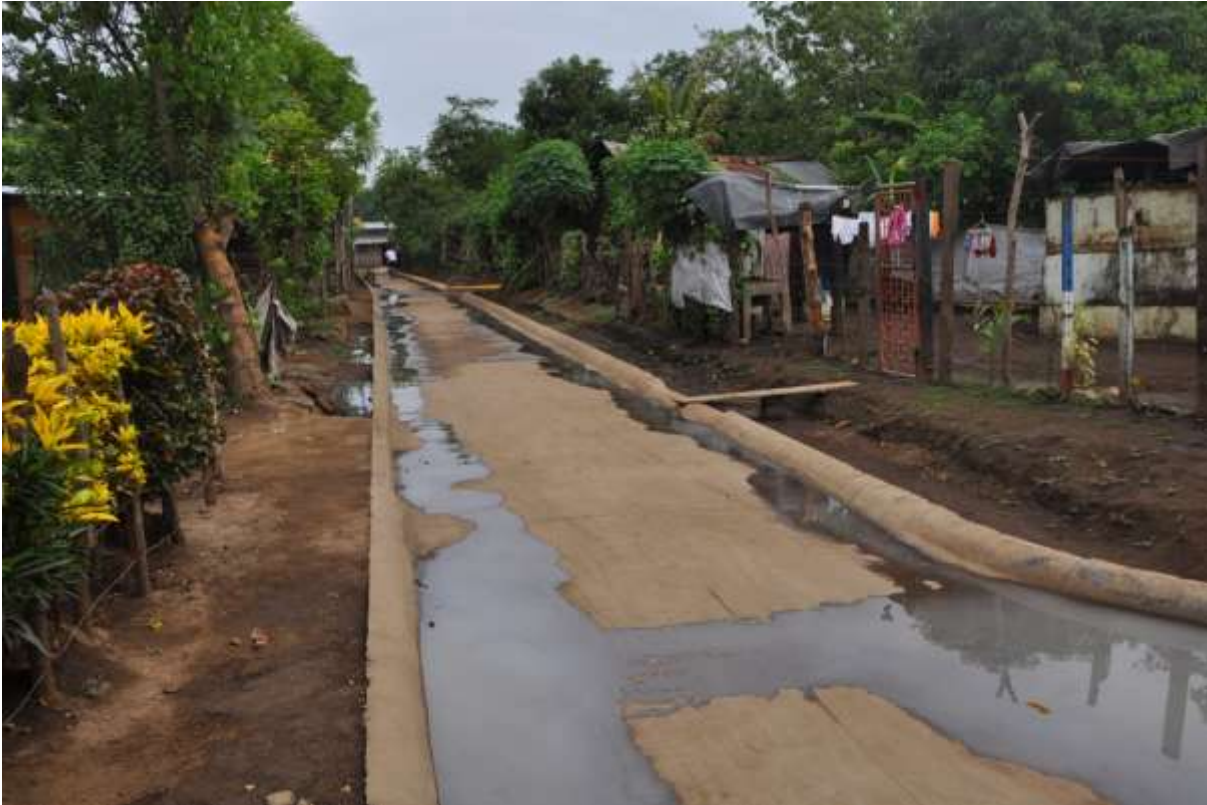
Ilustración 8.- Drenaje superficial a través de cunetas en El Viejo
