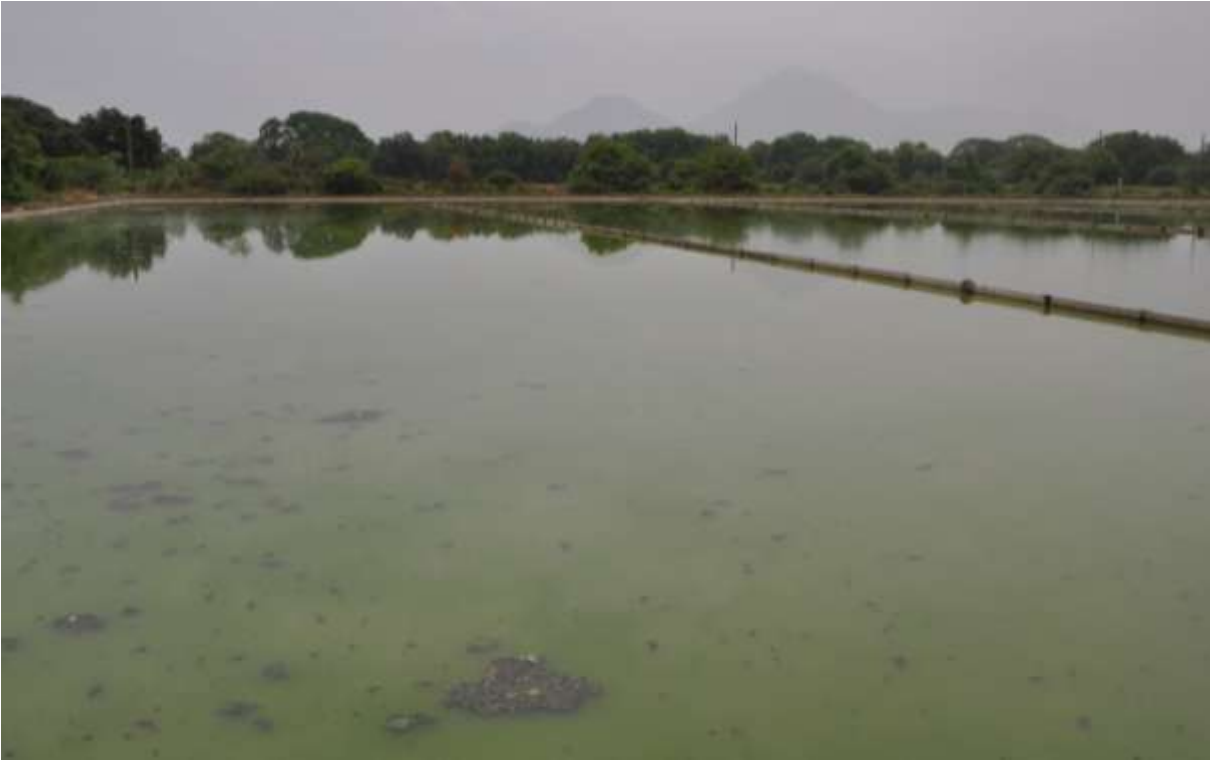
Ilustración 7.- Estado de la PTAR de El Cementerio, en Chinandega
