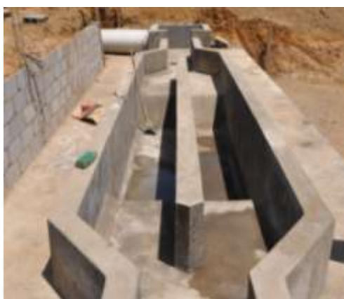
Figura 3.-Vista en planta del desarenador
