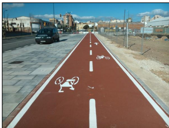
Imatge 3. Carril bici amb paviment asfàltic
