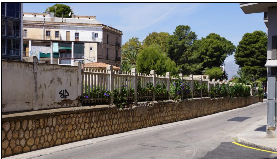
Imatge 6. Mur que suporta el terraplè de les antigues vies.
