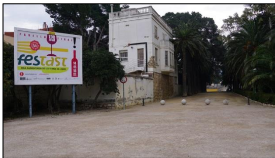
Imatge 5. Edifici de dues plantes.
