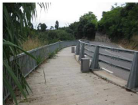
Paviment formigonat enrasat
