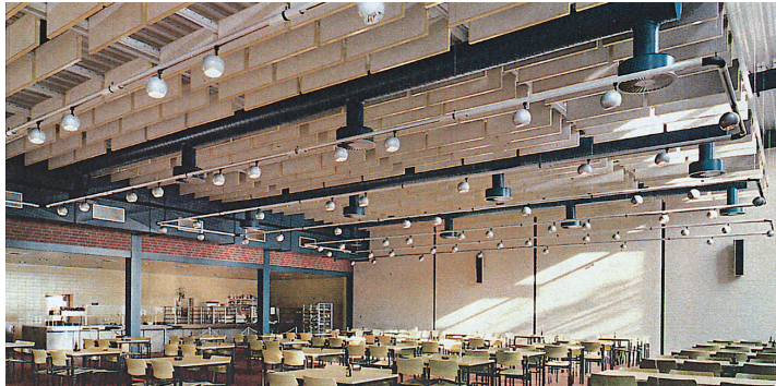
Fig. 2.18 Ejemplo de tratamiento acústico de un techo a base de baffles rectangulares absorbentes de lana mineral comprimida (Eurobaffles de Eurocoustic, Cristalería Española, S.A.)
