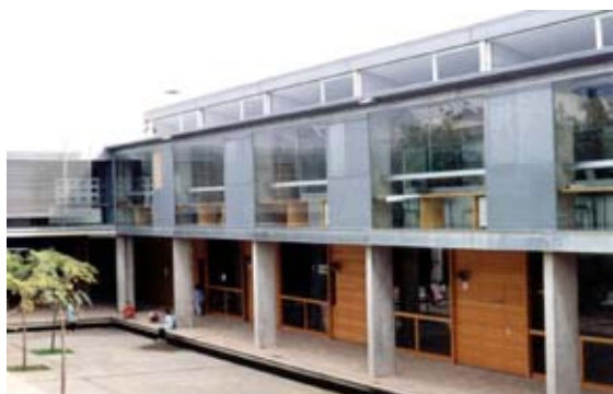
Vista de uno de los pabellones desde el patio
