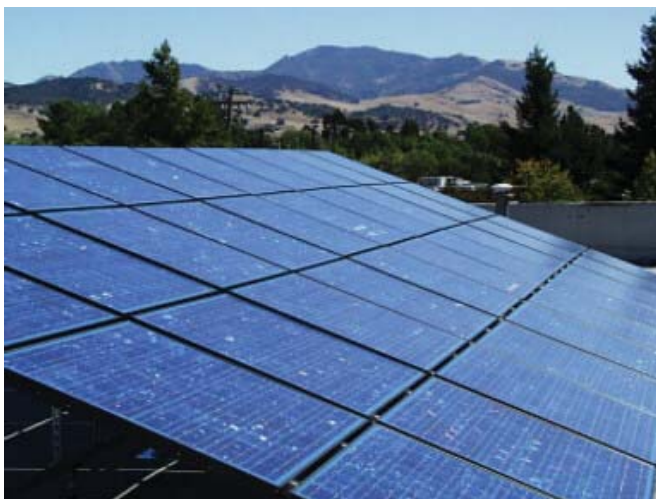
Fig. 1.15 Part del camp de panells fotovoltaics a Zambelli, nord d'Itàlia, produeix fins a 70 kW d'electricitat a fi de bombejar aigua potable a un poble de muntanya. Per assegurar un subministrament continu, 24 hores al dia, part de l'energia va a un conjunt de bateries. Quan la producció elèctrica dels panells excedeix la demanda es pot emmagatzemar també l'aigua bombejada (Font: ENEA, Roma, Itàlia).
