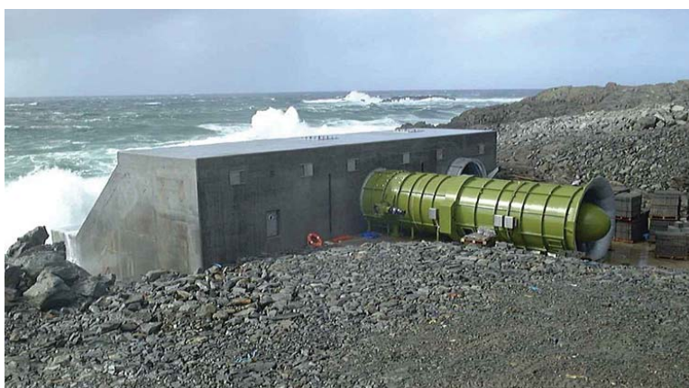
Fig. 1.12 Imatge de la central construïda a l'illa de Islay coneguda per projecte LIMPET (Land Installed Marine Powered Energy Transformer) i desenvolupat conjuntament per l'empresa Wavegen i la Queen's University de Belfast. (Font: Wavegen, Regne Unit).
