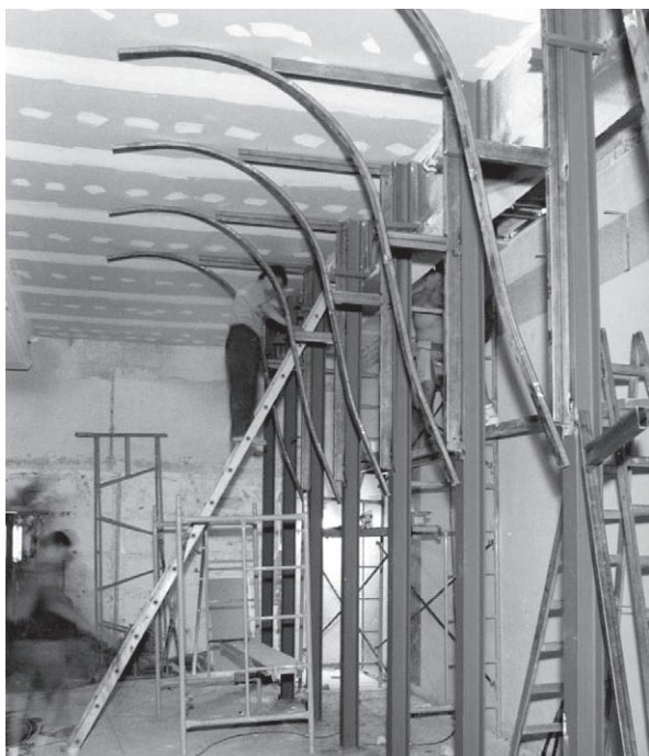
Fig. 8.16 Tornaveu de l'escenari de la sala d'actes de l'ETSEIB, en construcció (fotografia de la UPC)
