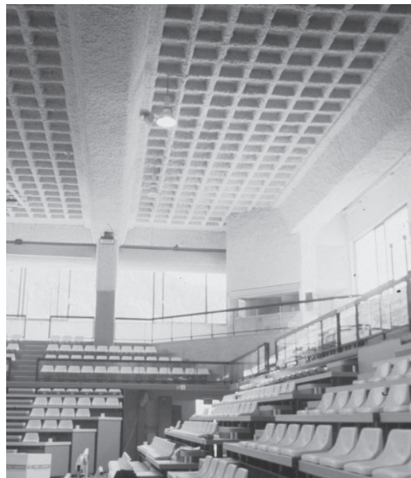
Fig. 8.40 Estat de la sala del Poliesportiu d'Escaldes Engordany, a) durant i b) després de la projecció de material absorbent (fotografies de l'autor)
