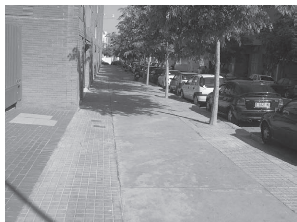
Fig. 5.47 Galeries de serveis a la Vil·la Olímpica (fotografia de l'autor)
