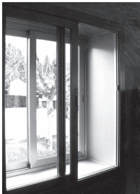
Fig. 6.19 Doble finestra (independent) amb cambra d'aire, al Centre Cívic de Navarcles (fotografia de l'autor)
