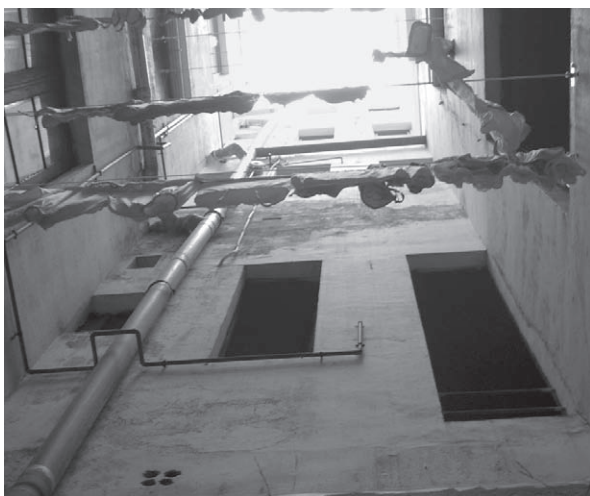
Fig. 6.33 Pati de llums i ventilació d'un edifici (fotografia de l'autor)
