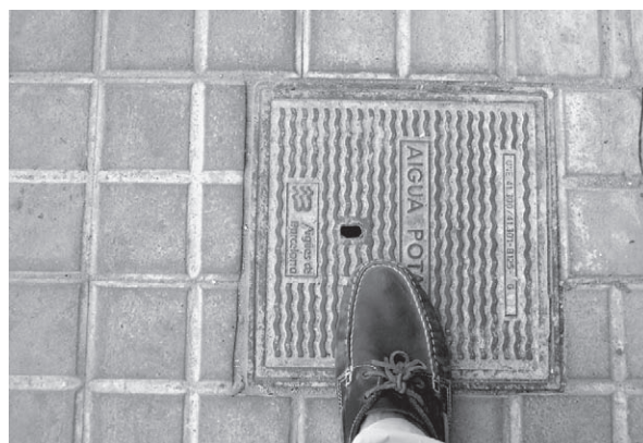
Fig. 5.34 Tapa de registre d'instal·lacions urbanes (fotografia de l'autor)
