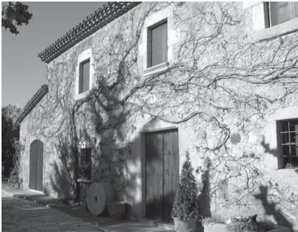
Fig. 6.8 Façana ombrejable de "Can Xevi". Santa Cristina d'Aro, Girona (fotografia de l'autor)
