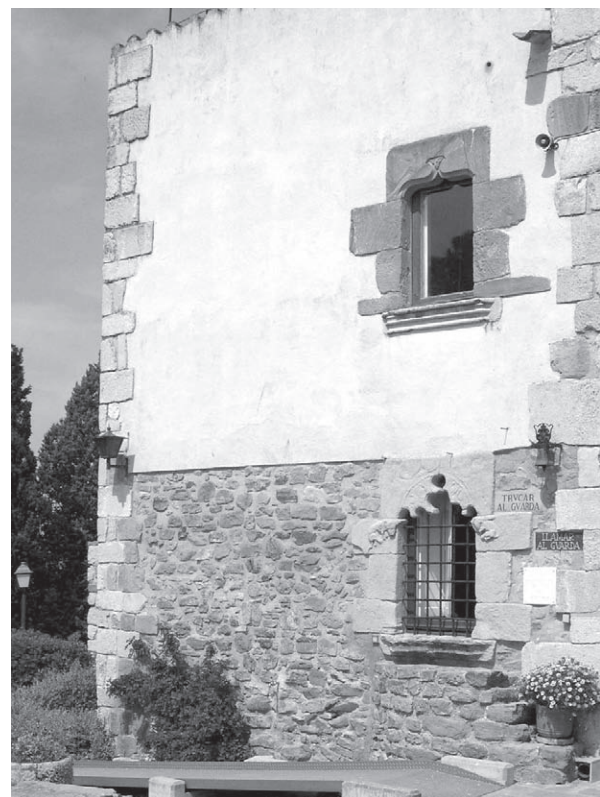
Fig. 6.23 Baixa relació buit-ple de la façana del Museu d'Ullastret, Girona (fotografia de l'autor)
