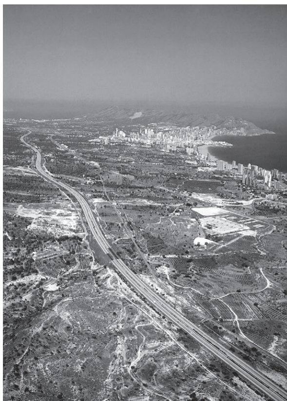
Fig. 4.4 Infraestructura dissenyada per l'ésser humà (fotografia aèria de l'autopista de Llevant)
