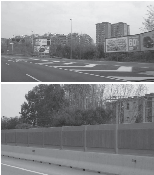
Fig. 6.1 a) Desprotecció i b) protecció sonora des de la font de soroll fins a l'edifici (fotografies d'autor)
