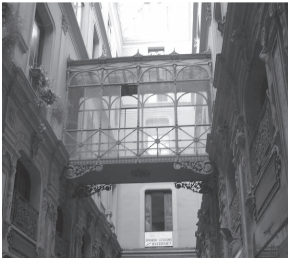
Fig. 2.9b Pont entre cases en un carrer de Barcelona (fotografia de l'autor)
