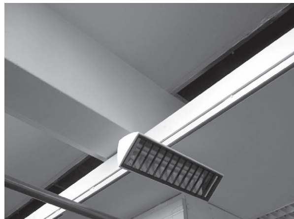
Fig. 8.23 Trampes de so al passadís d'exposicions de l'ETSEIB (fotografia de l'autor)
