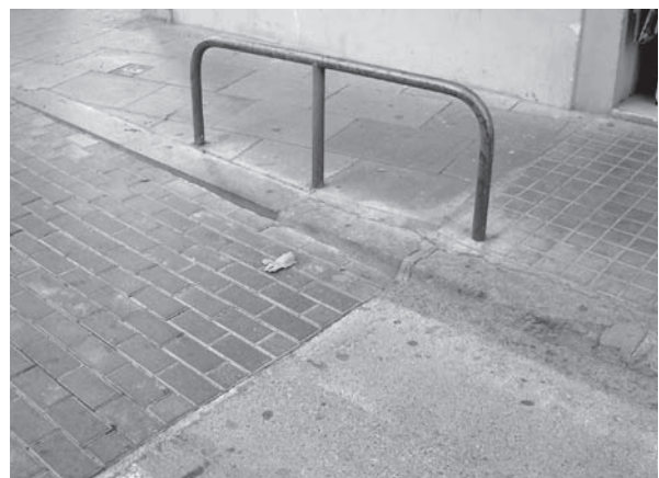
Fig. 5.43 Canvi de textura d'un carrer a Barcelona (fotografia de l'autor)
