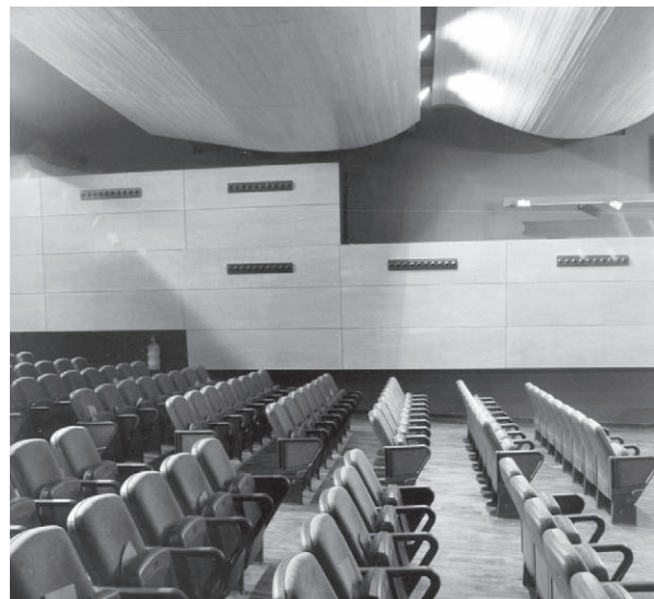
Fig. 7.27 Absorbents de membrana a l'ETSEIB (fotografia UPC)
