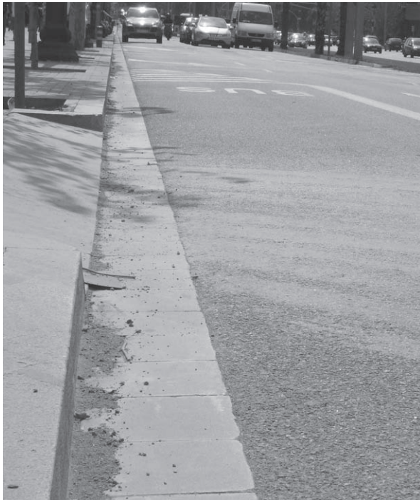
Fig. 5.44 Pellada de material a la Diagonal de Barcelona (fotografia de R. Calafell)
