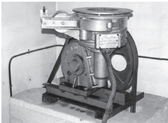
Fig. 6.28 Maquinària d'ascensor abans d'aïllar-la (fotografia de l'autor)
