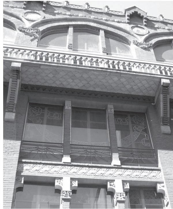
Fig. 8.26 Detall del nou vidre laminat implantat a la rehabilitació del Palau de la Música Catalana
