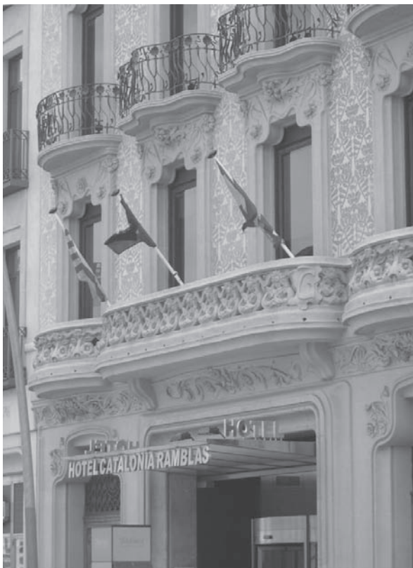
Fig. 6.6 Rehabilitació integral. Transformació de les oficines de La Vanguardia a l'Hotel Catalonia (fotografia de l'autor)
