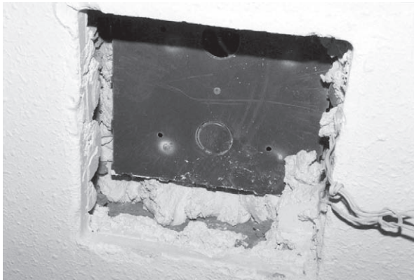
Fig. 7.38 Enfrontament de caixetins en una paret (fotografia de l'autor)
