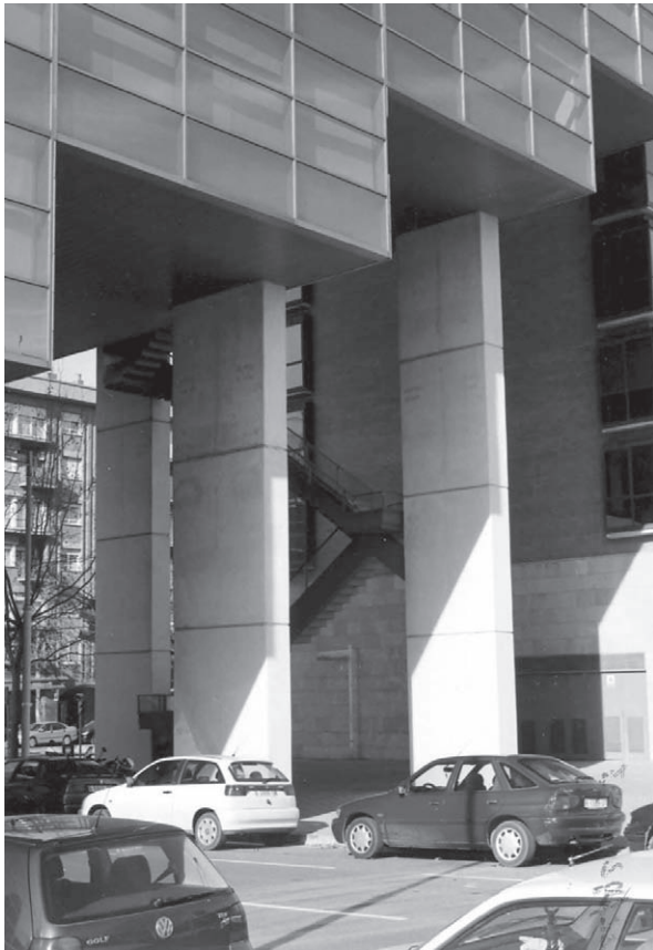
Fig. 5.51b Tractament sota balcó, ràfecs i volades (fotografia de l'autor)
