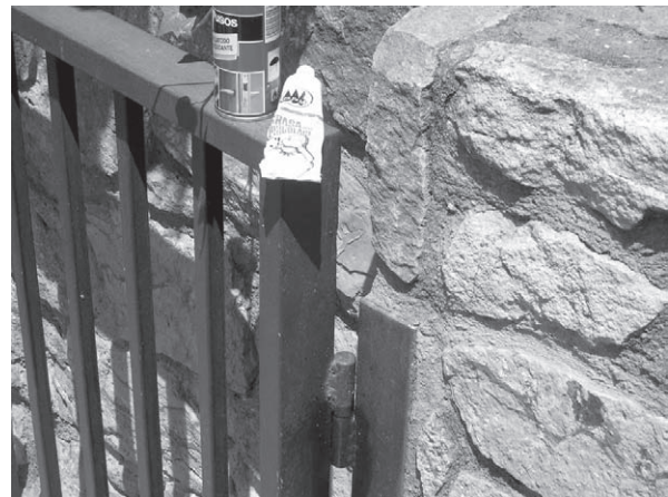
Fig. 7.63 Greixatge de les frontisses d'una porta (fotografia de l'autor)
