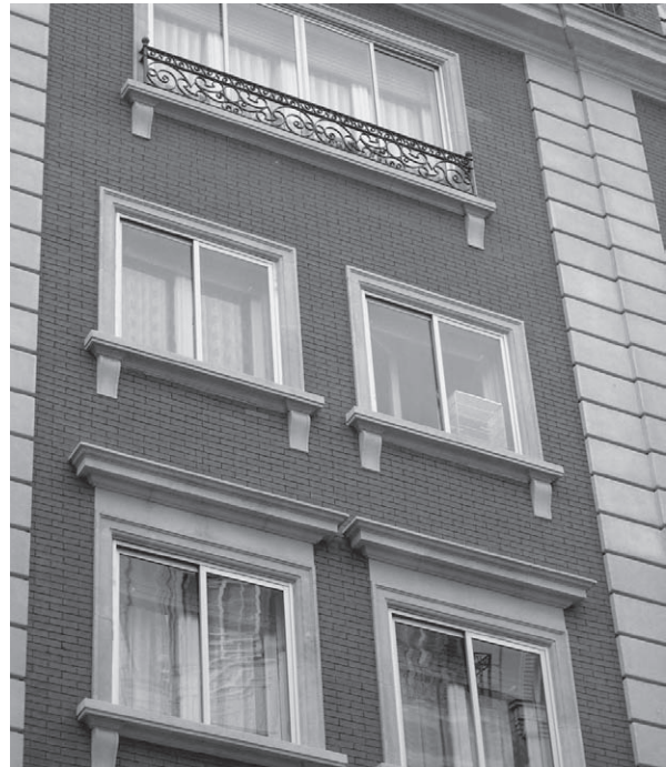
Fig. 6.22 Façana de rehabilitació unitària (fotografia de l'autor)
