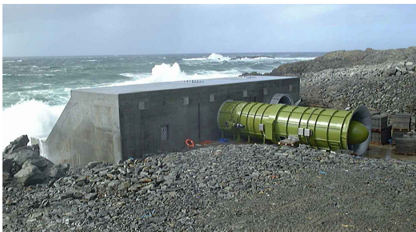
Fig. 1.12 Imatge de la central construïda a l'illa de Islay coneguda per projecte LIMPET (Land Installed Marine Powered Energy Transformer) i desenvolupat conjuntament per l'empresa Wavegen i la Queen's University de Belfast. (Font: Wavegen, Regne Unit).
