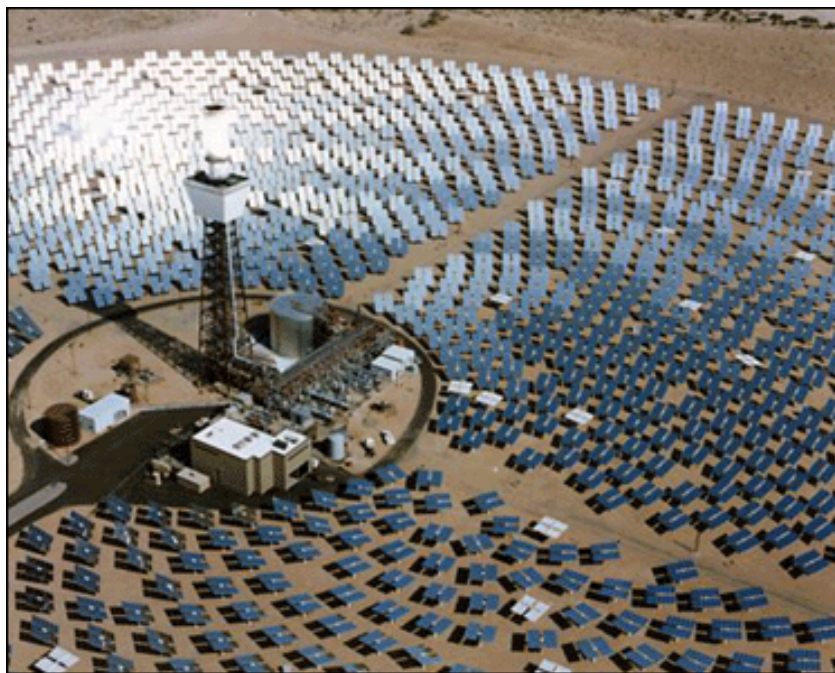
Fig. 1.16 L'any 1982 entra en funcionament la central d'energia solar Solar One, a Barstow (Califòrnia meridional). Mil vuit-cents divuit miralls, amb una superfície total de més de 70.000 m 2 , reflecteixen la llum solar i la concentren en una torre central que arriba fins als 1.000 °C de temperatura. Amb aquesta temperatura s'escalfa un líquid que posteriorment permet impulsar turbines i generadors elèctrics. Tots els miralls segueixen constantment l'òrbita solar mitjançant un comandament automatitzat. Solar One produeix 10 MW de potència elèctrica (Foto: Peter Menzel/Wheeler Pictures/Focus).
