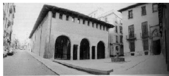
Fig.8. "El edificio del Almudín en su contexto urbano más inmediato; en primer término puede observarse la Plazuela de San Luis Beltrán, sobre la que se abre la espléndida fachada frontal de la edificación". Revista "ON DISEÑO" No 185. Pag.102.
