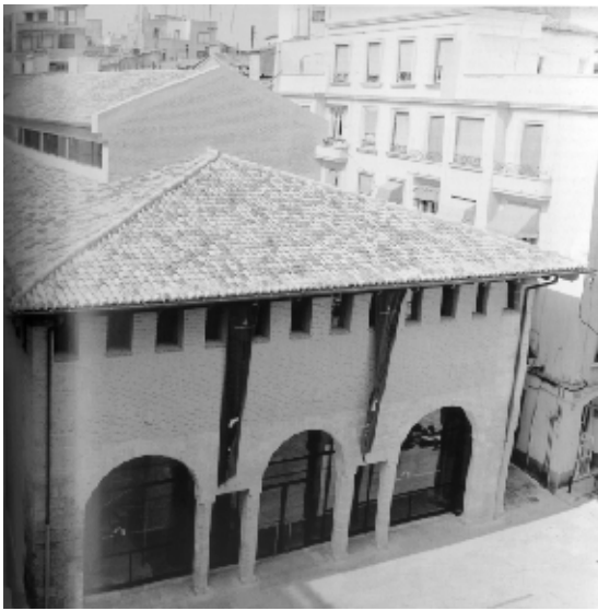
Fig.9. "Perspectiva superior del edificio. La intervención ha supuesto la recuperación de la primitiva configuración de cubiertas superiores, sumamente alteradas a lo largo de la historia del edificio". Revista "ON DISEÑO" No 185. Pg.103.
