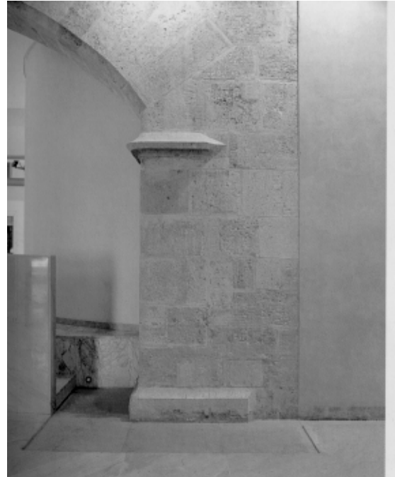
Fig. 15. “La unidad de la propuesta se materializa en el mármol de Carrara y la madera utilizados como revestimiento, además de la piedra de la construcción original” Revista “DISEÑO INTERIOR” No 47. Pg. 31.
