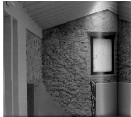
Fig.4. "desembarco de la escalera a nivel de la planta segunda. La cubierta del ámbito longitudinal, destinado a las oficinas de gestión y dirección del espacio protegido, dispone de un lucernario que recorre en toda su longitud, para complementar la escasa iluminación natural proporcionada por los escasos huecos de sus fachadas exteriores." Revista "ON DISEÑO" No 180. Pg.121.
