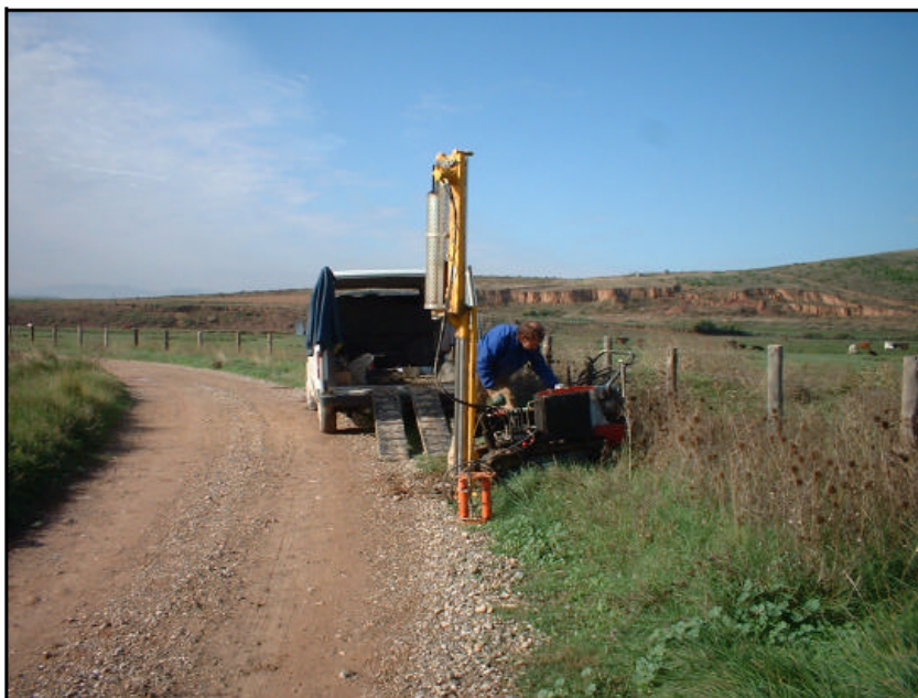
Foto 2: : Emplazamiento del ensayo de penetración n° 2.
