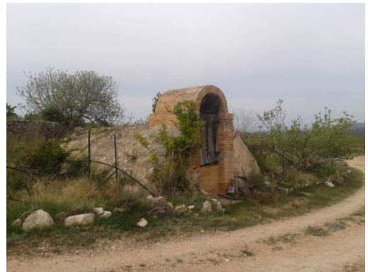
Figura 3.1.4: Cisterna de agua
