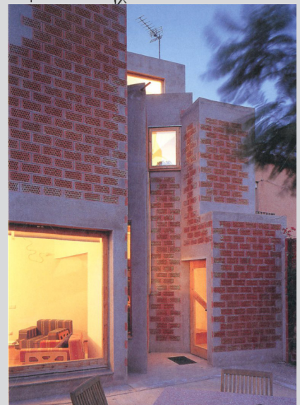
Figura 169 Vista exterior de la casa en "La Clota"
