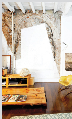
Figura 77 Arcos góticos piso en la calle Mercaders
