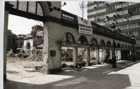
Figura 31 Derribo del antiguo mercado de Santa Caterina
