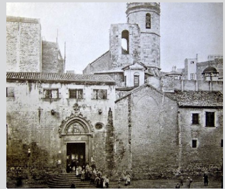
Figura 30 Antiguo convento de Santa Caterina
