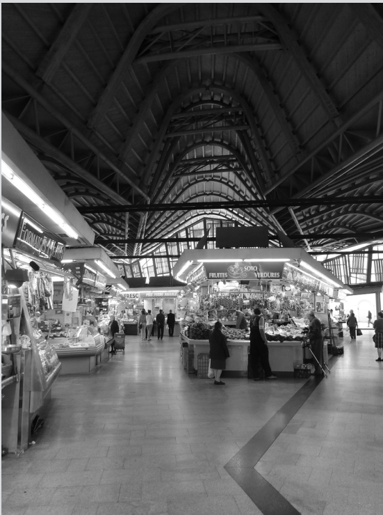
Figura 134 Vista interior del nuevo Mercado
