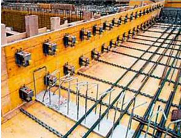
Figura 2.9 A la dreta mecanisme Goujon Cret, a l'esquerra, disposició dels passadors abans de formigonar.
