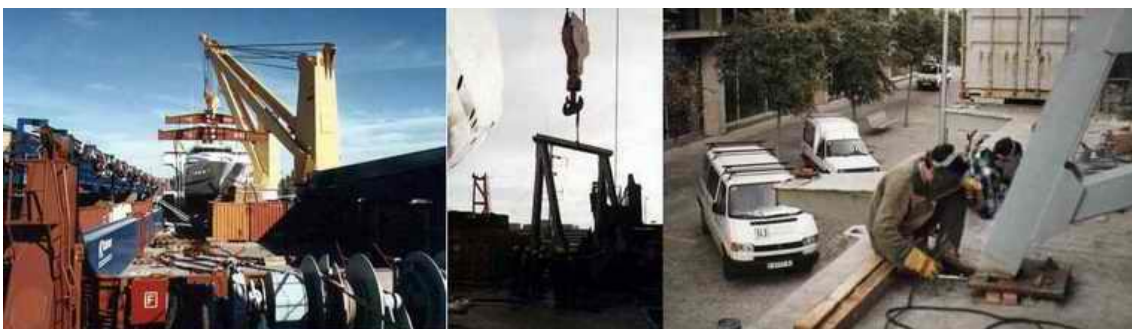
Colocar y soldar estructura de soporte
