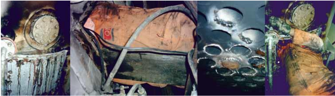
Reparación en caldera
