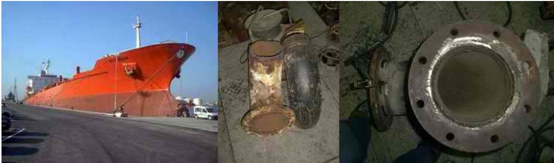
Sustitución de codo a bordo del buque
