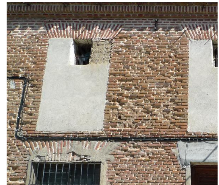
Imatge 8.1-3: maons erosionats. Font: pròpia.
