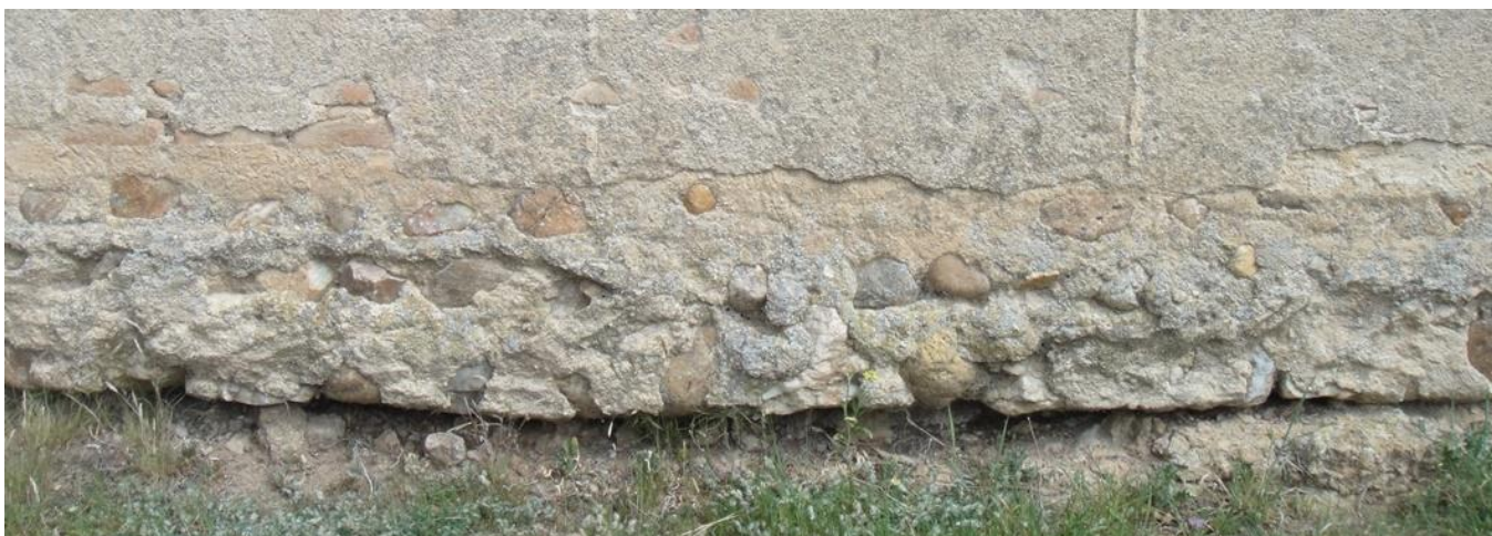
Imatge 5.5-1: Fonaments, part del mur exterior de maó i revestiment. Font: pròpia.
