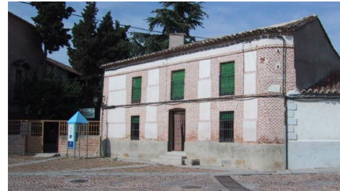
Imatge 3.1-1: Casa de gent acomodada. Font: Fitxa nº75 de les NUM. Font: pròpia.
