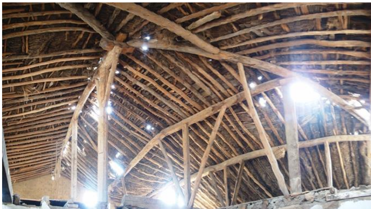
Imatge 8.5-1: Coberta foradada d'un habitatge en desús. Font: pròpia.
