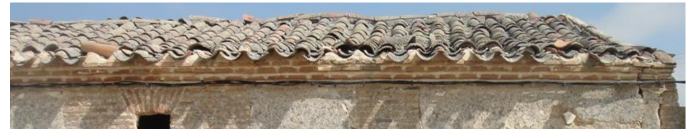
Imatge 5.4-2: Coberta d'un edifici en ruïnes. Font: pròpia.
