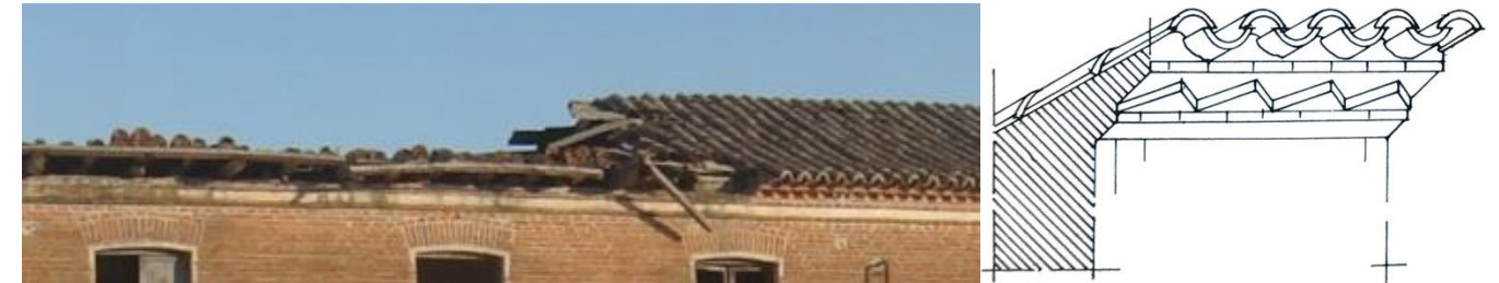
Imatge 4.4-1: Coberta d'un edifici en ruïnes. Font: pròpia.
