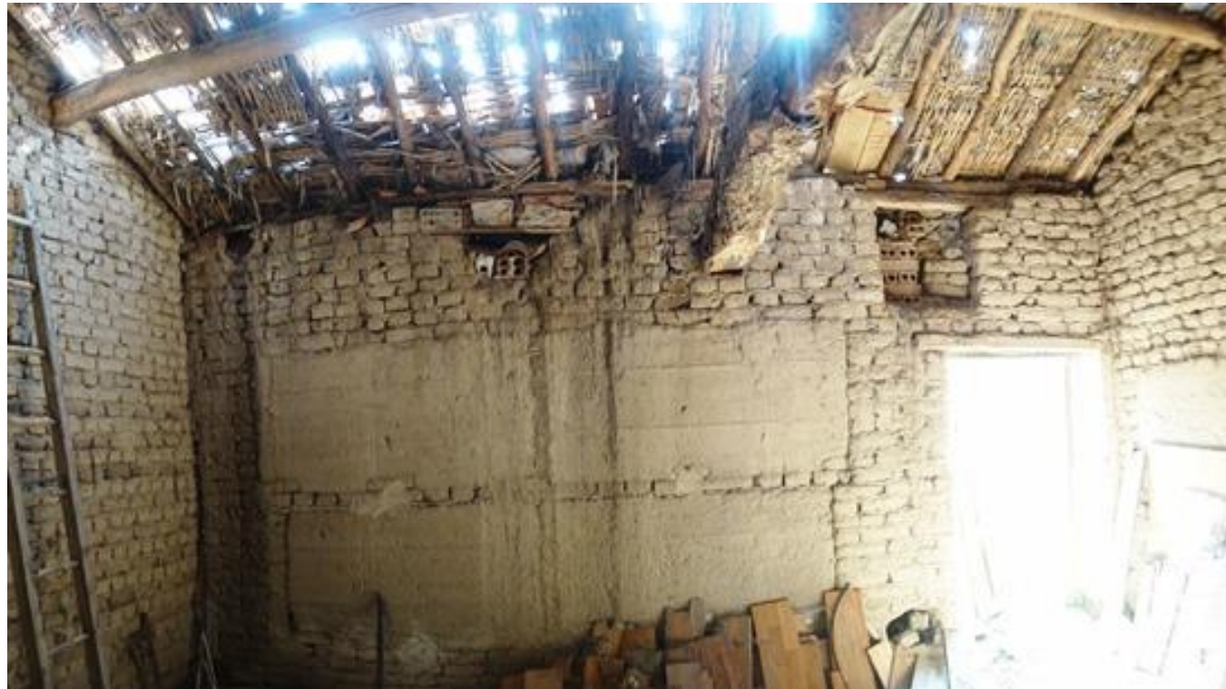
Imatge 4.1-1: Mur mixt de tova i tàpia d'un corral. Font: pròpia.
