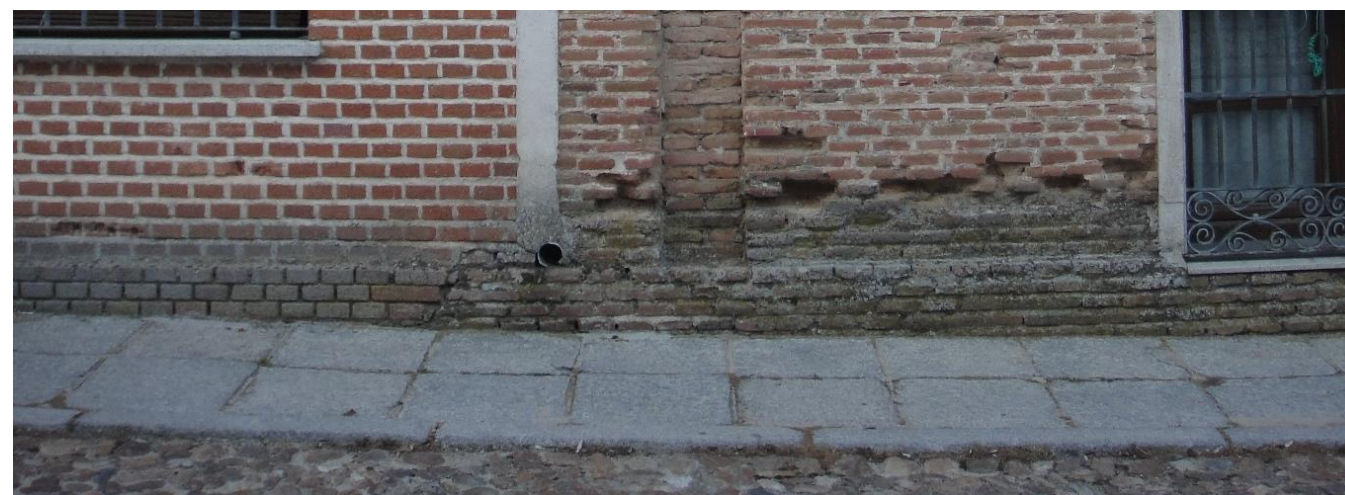
Imatge 5.4-1: Diferents tipus de maó de dos edificis. Font: pròpia.
