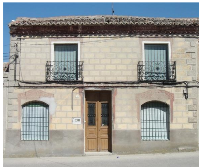
Fotografia de façana
