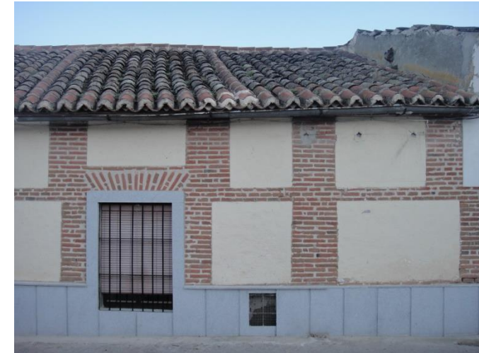
Imatge 8.1-1: revestiment parcial. Font: pròpia.
