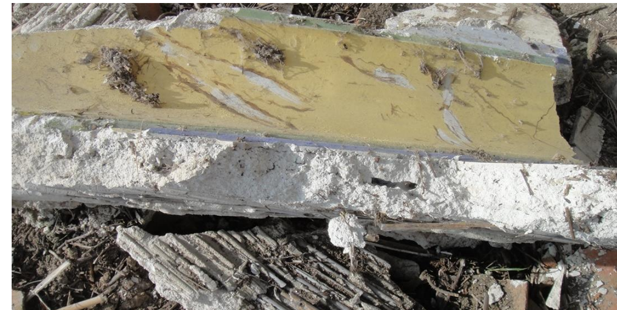
Imatge 5.2-1: Part de sostre de calç d'una casa en ruïnes. Font: pròpia.
