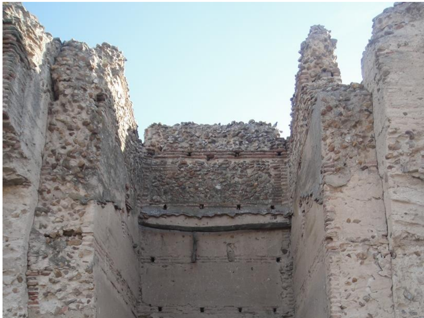
Imatge 1.4-1: Part superior d'un tram de muralla. Es pot apreciar bé la tècnica del "calicanto". Font: pròpia.
