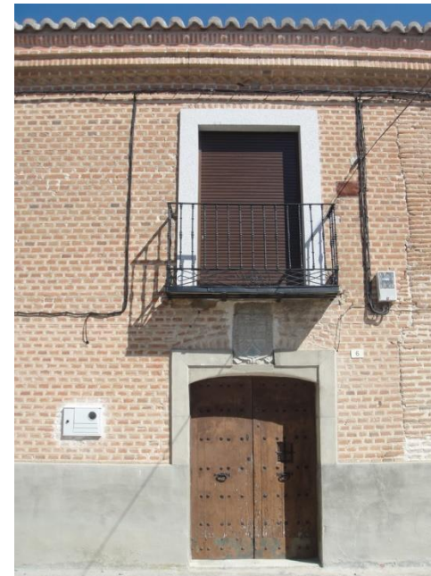
Imatge 8.1-2: revestiment total. Font: pròpia.
