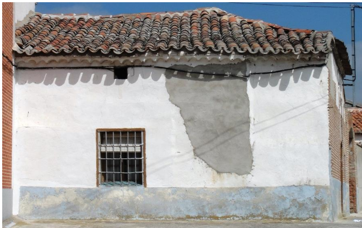
Imatge 8.1-6: exemple de ho arreglem amb morter. Font: pròpia.
