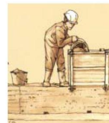
Imatge 5.6.6-4: Abocar la terra dins l'encofrat.
