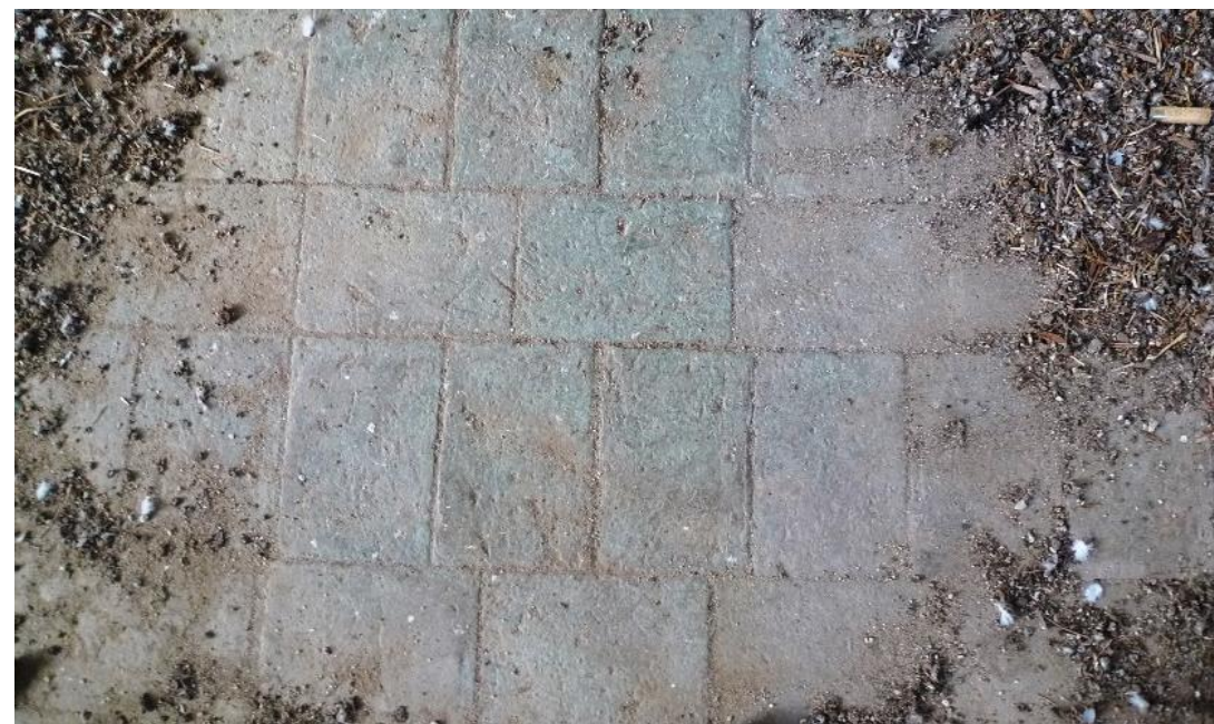
Imatge 4.7-1: Paviments ceràmics on se separen dues estances. Veiem els dos paviments. Font: pròpia.
