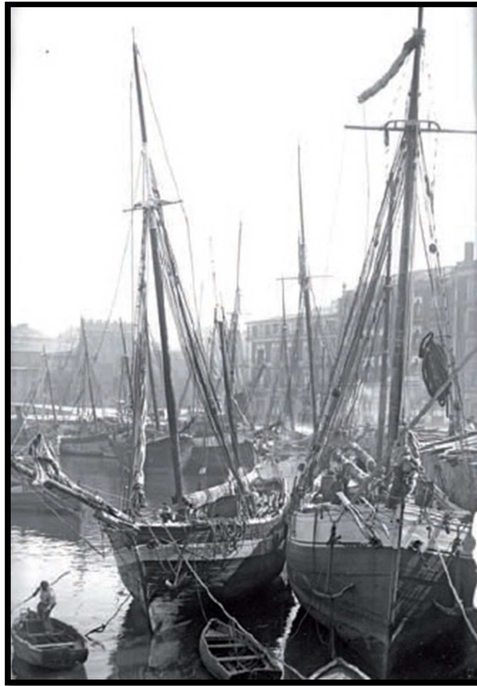
Ilustración 2: La dársena del puerto viejo de Gijón.
