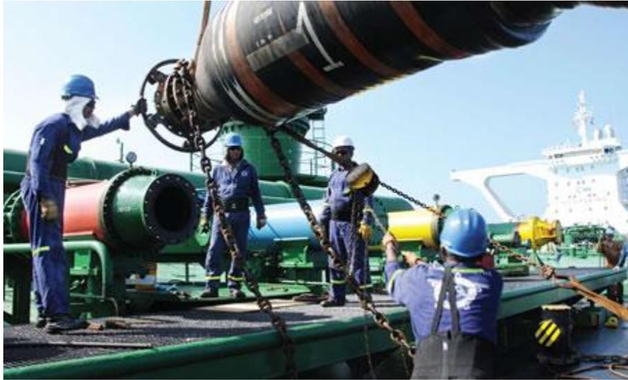
Figura 18: Conexiones entre terminal y barco, manifolds (fuente: web de ecopetrol)
