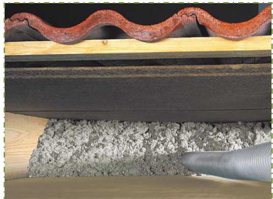
Ilustración 14 Aplicación de celulosa por inyección mecánica en cámaras frías y cavidades Fuente: Celulosa ISOFLOC http://aislaenverde.com/portfolio/celulosa
