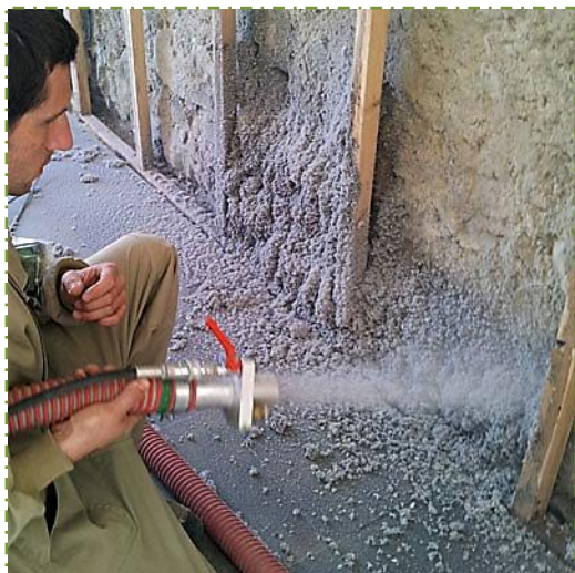
Ilustración 15 Instalador proyectando el tabique con celulosa. Fuente: Celulosa.pro
