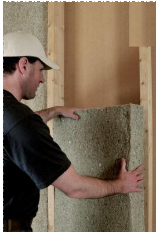
Ilustración 21 Instalación del panel de celulosa a un tabique.
