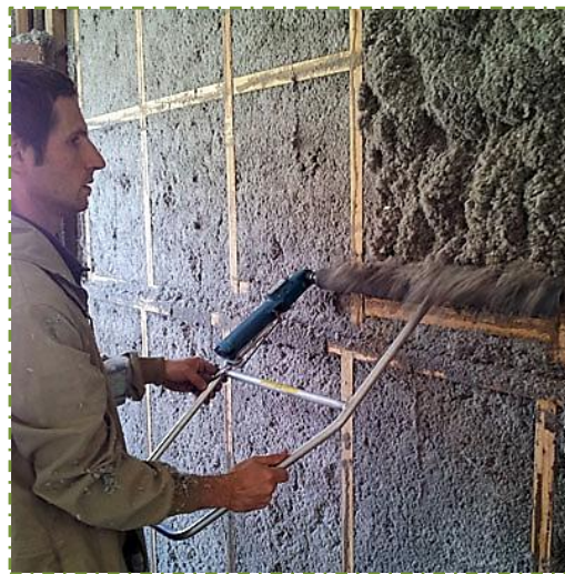
Ilustración 16 Instalador rastrillando la zona proyectada para estabilizar la mezcla. Fuente: Celulosa.pro
