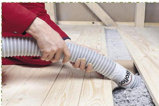
Ilustración 11 Muestra de inyección mecánica de la celulosa. Fuente http://aislaenverde.com/portfolio/celulosa/
