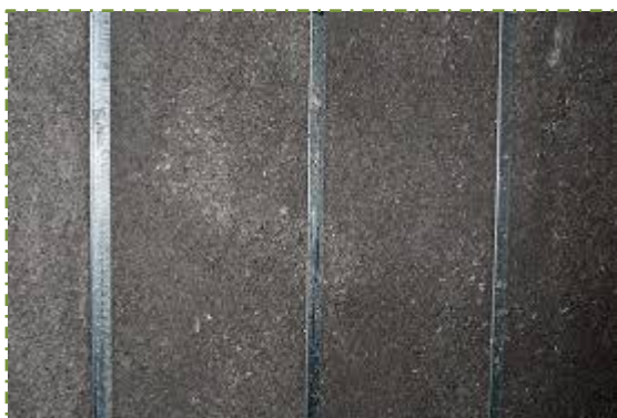
Ilustración 17 Muestra de cómo queda la zona proyectada después de rastrillar. Fuente: www.aisleco.com
