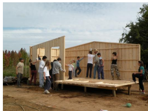
Montaje de paneles
