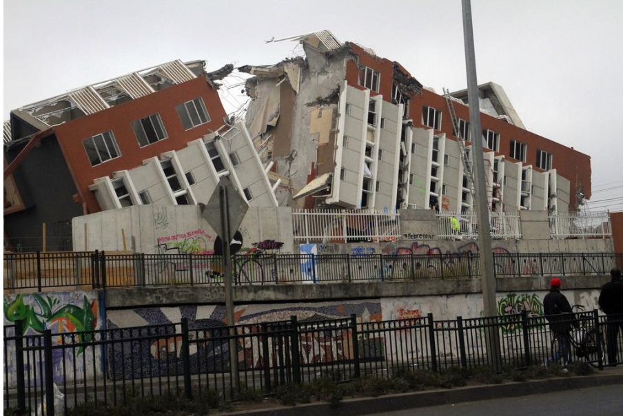
Imagen 61: Edificio Alto Río, ciudad de Concepción, Chile año 2010
