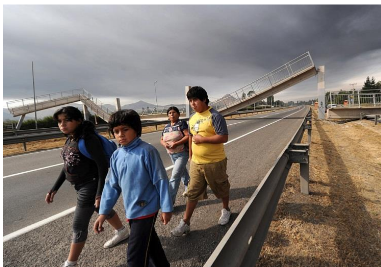
Imagen 1: Pasarela peatonal autopista Aconcagua, norte de Santiago
