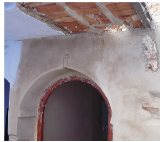
Imatge 49. Losa de alero de entrevigado de ladrillo macizo y vigueta metálica.
