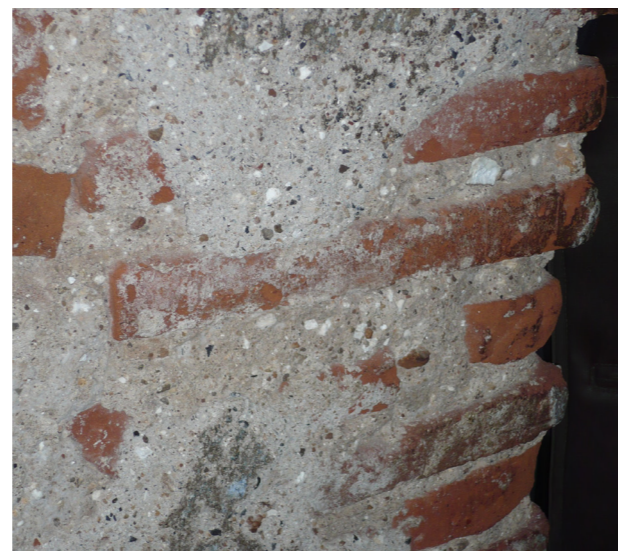
Imatge 28. Jamba ladrillo macizo
