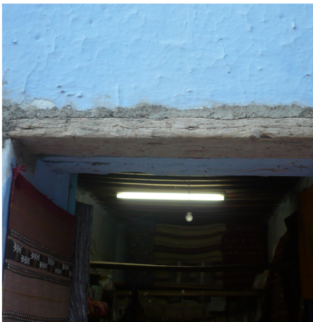
Imatge 35. Dintel de madera.
