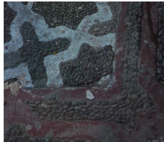
Imatge 42. Pavimento de mortero decorativo.
