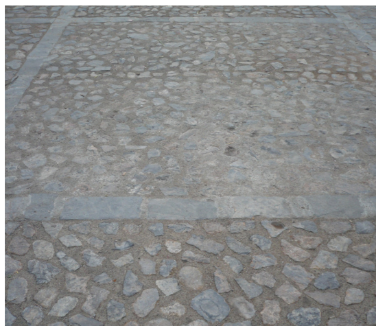
Imatge 43. Pavimento de piedra.
