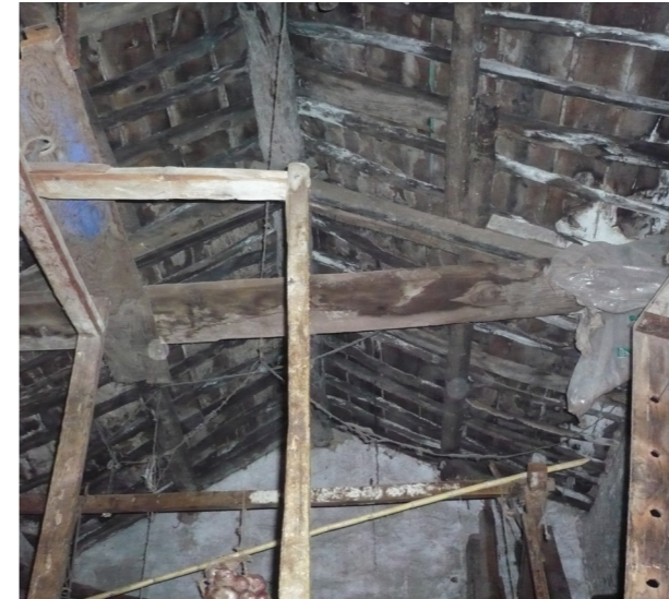
Imatge 14. Cercha, par, tirante y viga.
