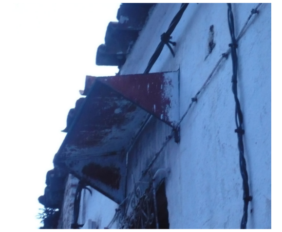
Imatge 50. Alero de chapa metálica.
