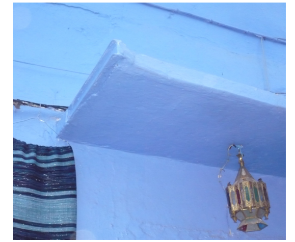
Imatge 48. Losa de alero con acabado enfoscado.
