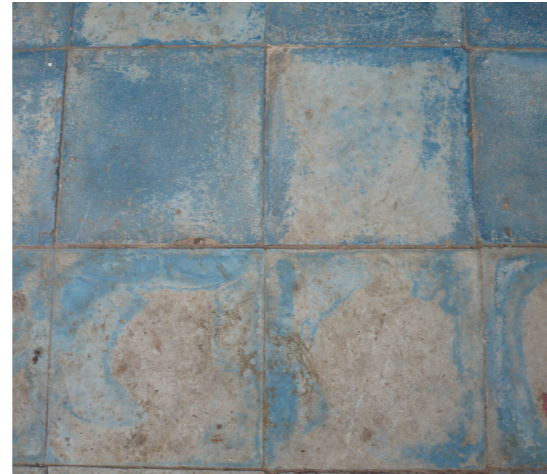
Imatge 40. Pavimento de baldosa hidráulica.
