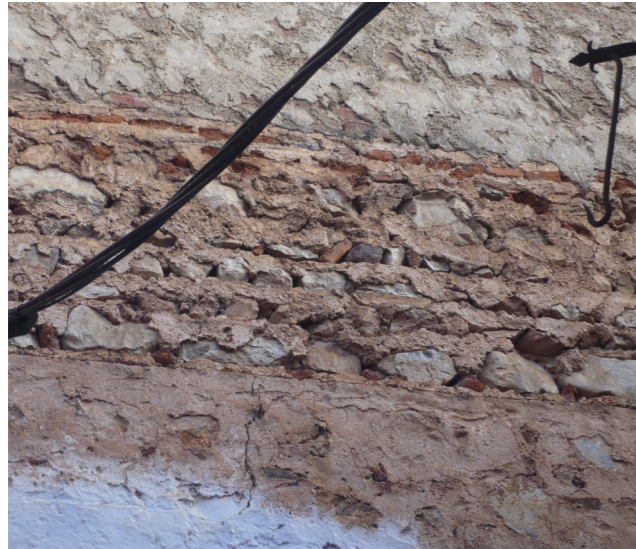
Imatge 10. Muro ladrillo macizo y piedra.
