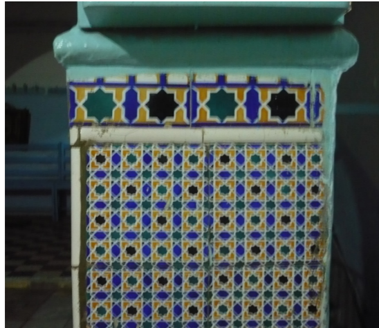
Imatge 39. Pavimento de baldosa cerámica esaltada.
