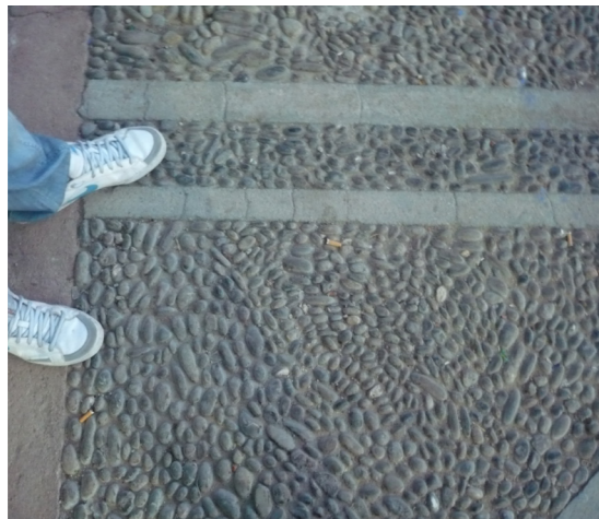
Imatge 41. Pavimento de canto rodado.
