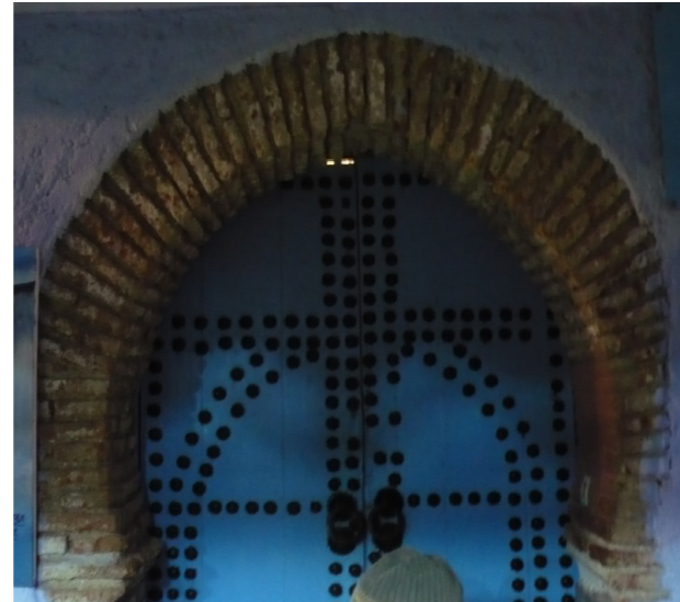
Imatge 11. Arco de ladrillo visto.
