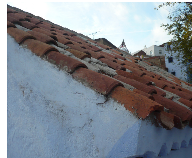
Imatge 24. Cubierta de teja cerámica árabe.
