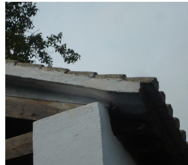
Imatge 23. Cubierta de hormigón prefabricado.
