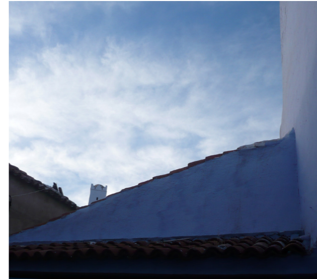
Imatge 21. Cubierta inclinada a una agua.
