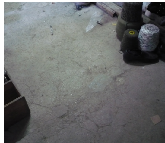
Imatge 44. Pavimento de mortero de cemento.
