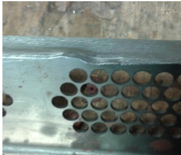
Imatge 37: Deformació de l'estructura
