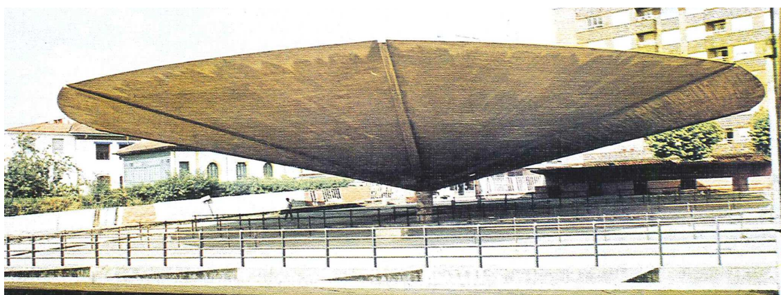
Fotografía 3: Paraguas antes de su primera reforma
