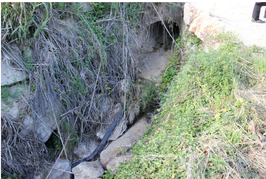
Imatge 1. 5. Punt final de la xarxa de sanejament actual.
