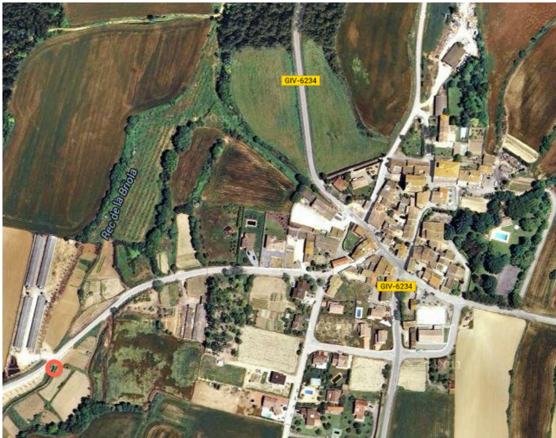
Imatge 1. 1. Vista aèria del nucli de Viladasens on s'indica el punt final de la xarxa de sanejament actual. Font: Google Maps.
