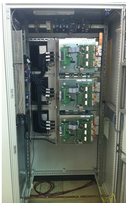
Figura I.5: Tercer compartiment del convertidor trifàsic
