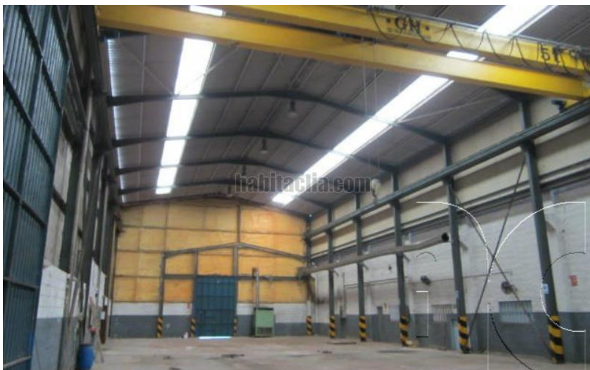
Fotografia 18: Magatzem nau escollida amb pont grua
