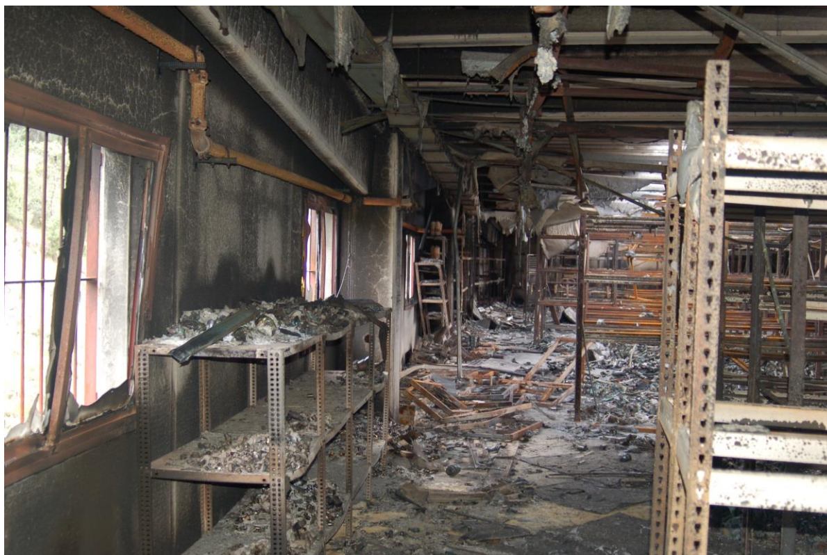
Fotografia 10: Danys en mercaderies i estructura de la nau primera planta
