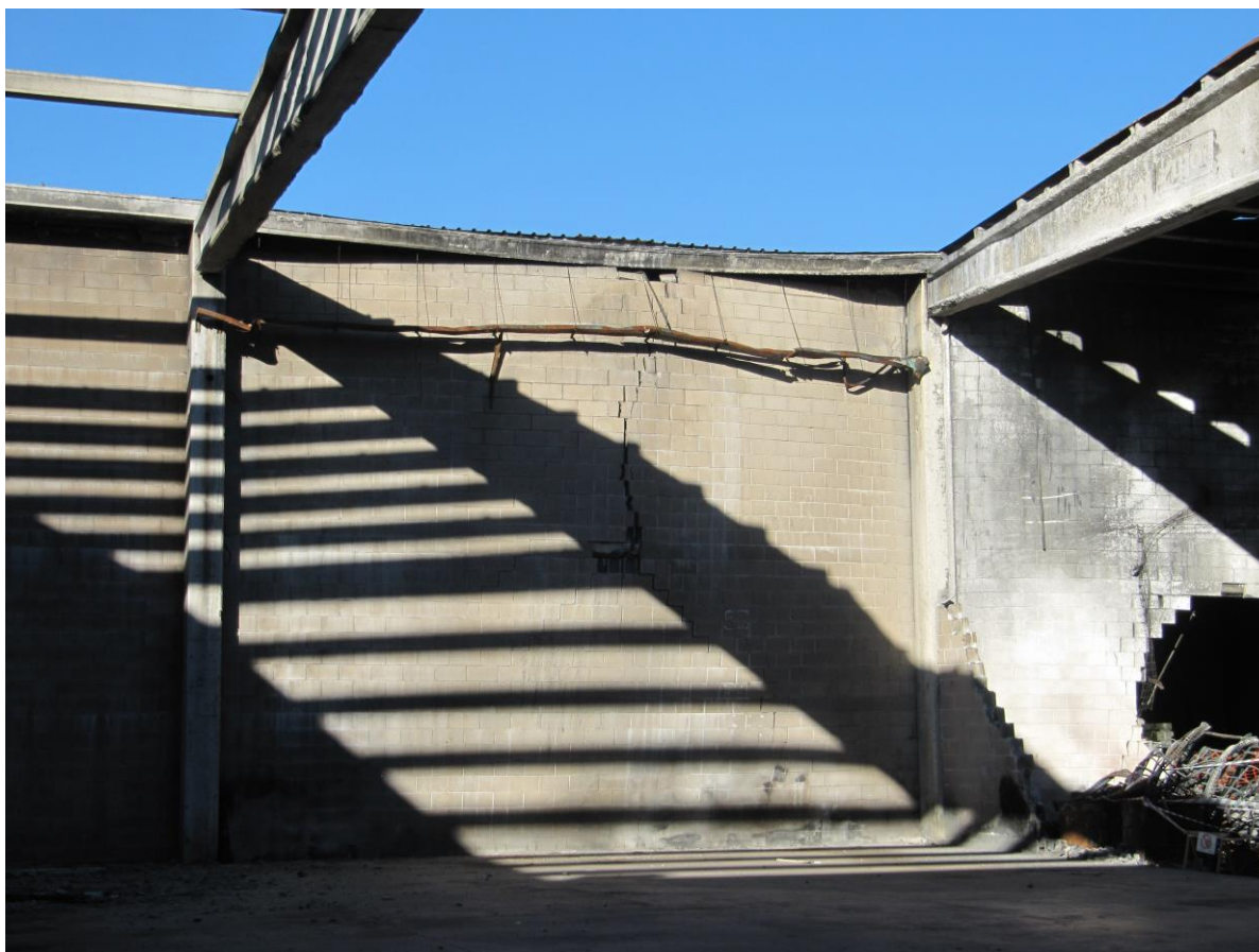
Fotografia 20: Estructura principal esquarterada
