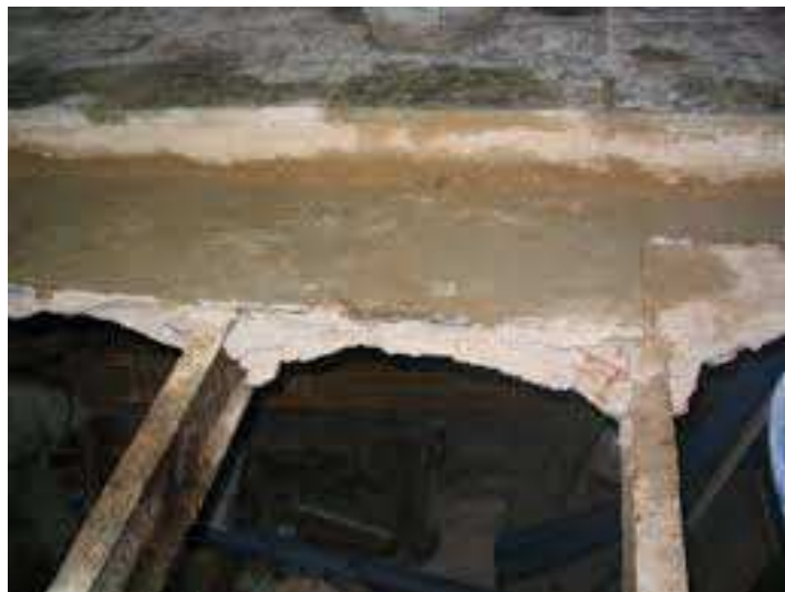
Deconstrucción de forjado sanitario.
