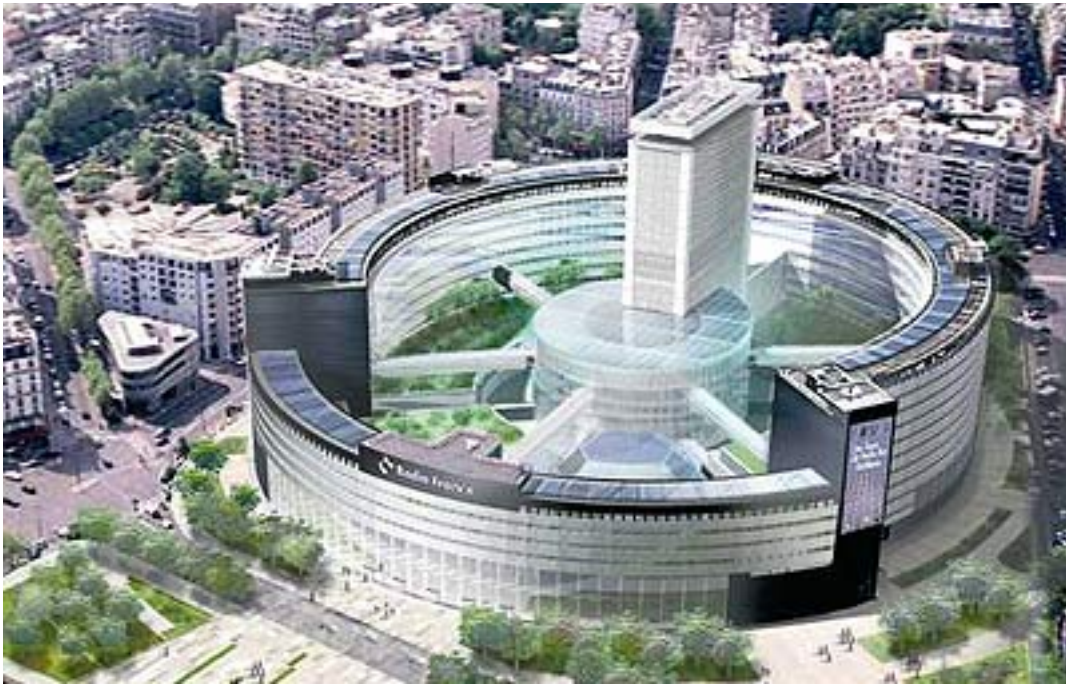
Figure 2.8. Maison de la Radio, Paris, France.
