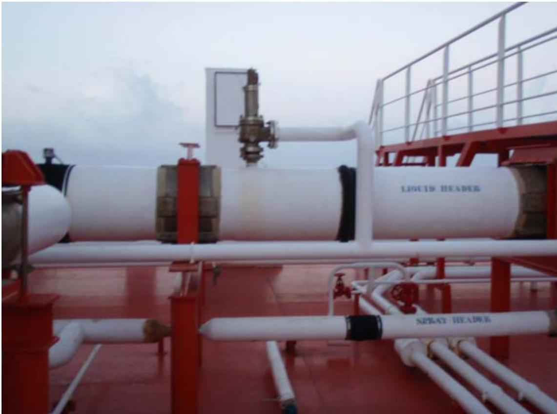
*Figura 81: Válvulas de seguridad en las líneas*
