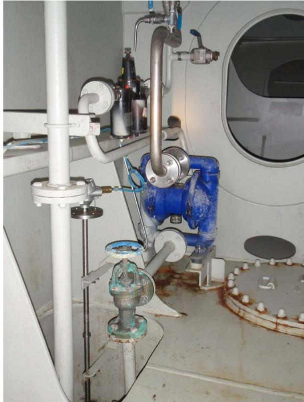
*Figura 37: Bomba neumática del cofferdam*
