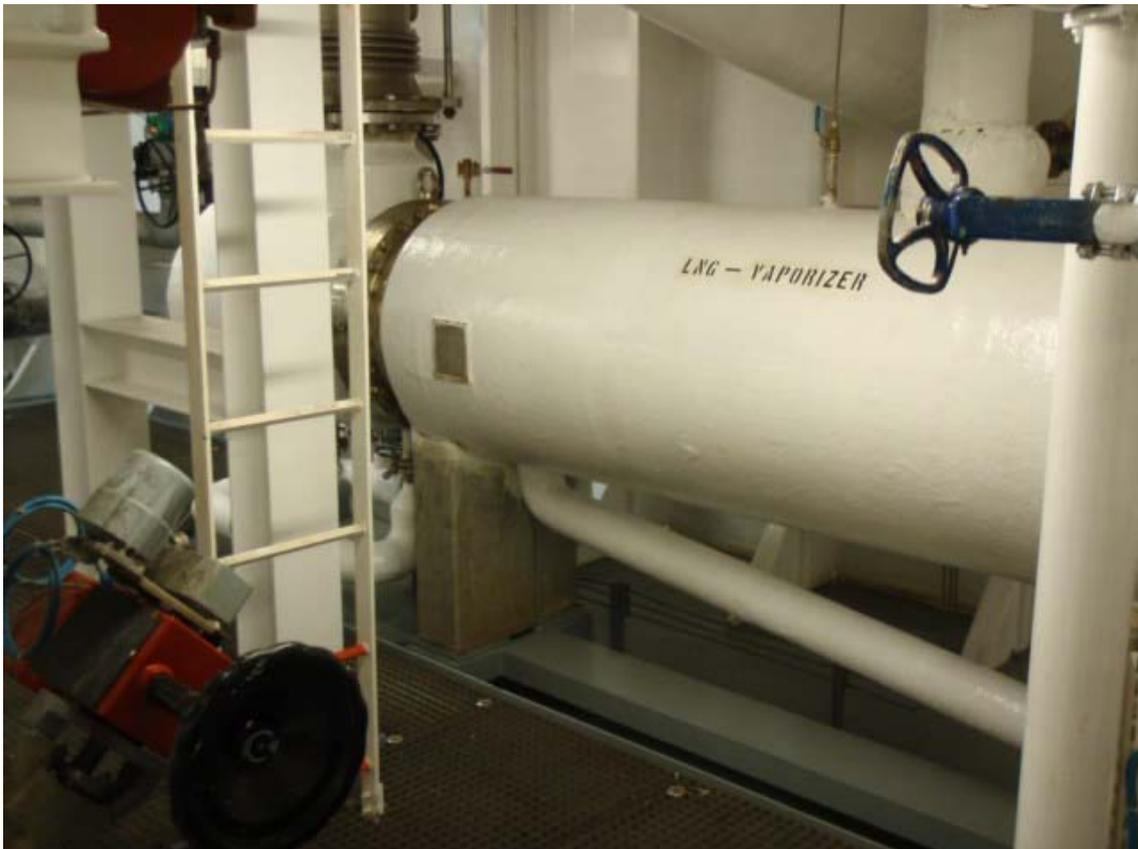
Figura 60: Esquema del vaporizador de LNG.
