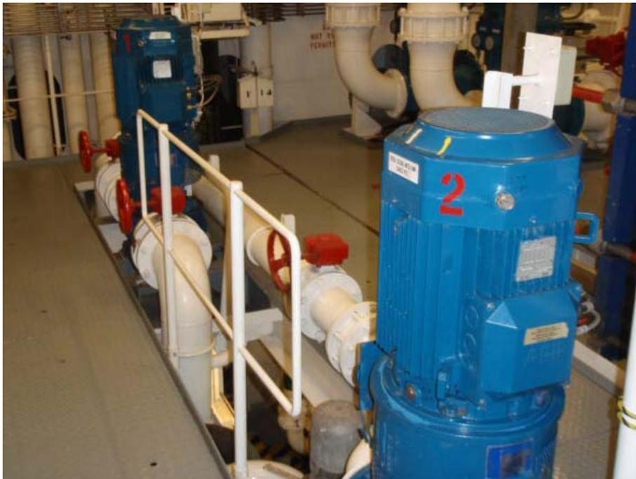
*Figura 97: Bombas de agua dulce de refrigeración*
