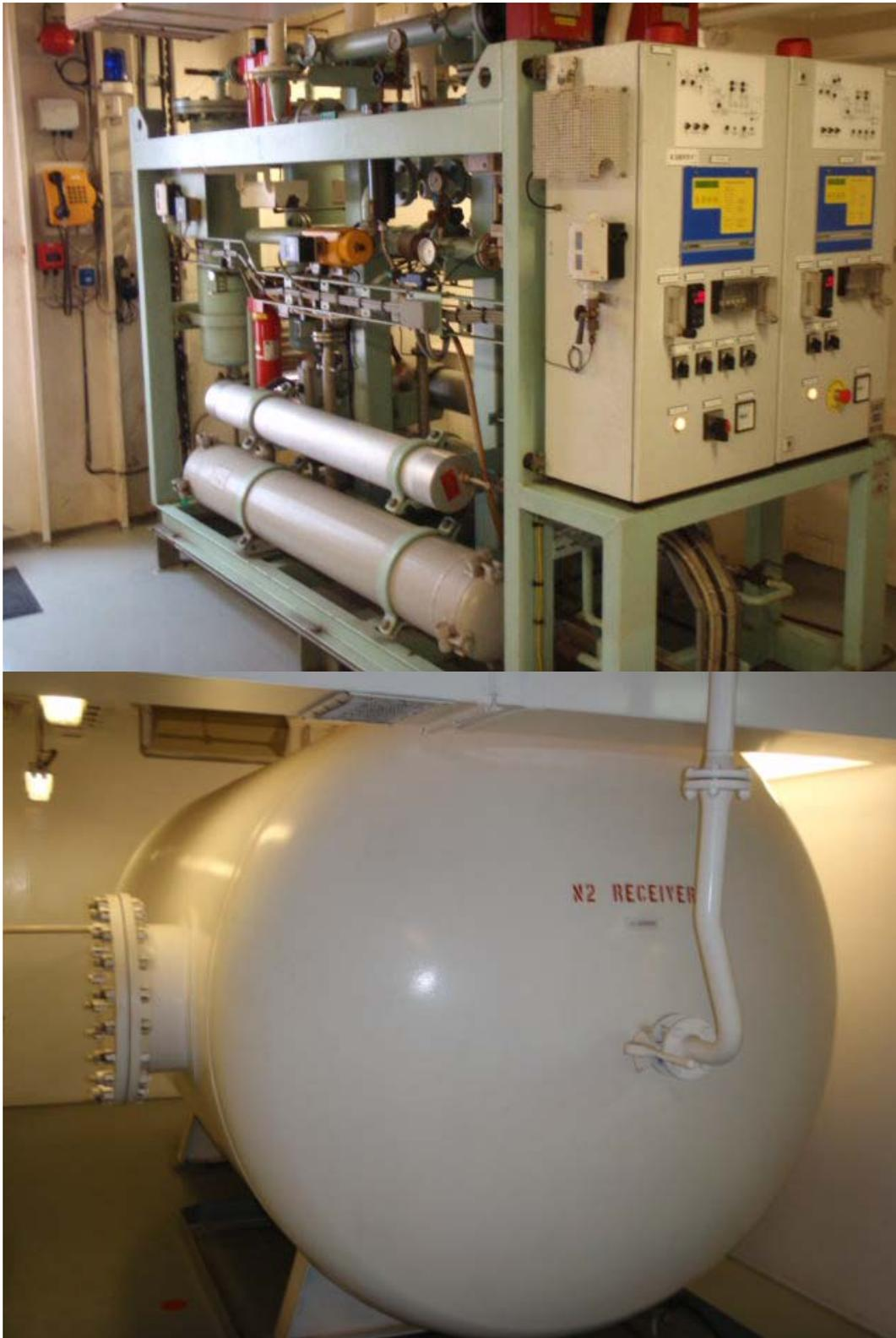
*Figura 65: Generador de nitrógeno*
