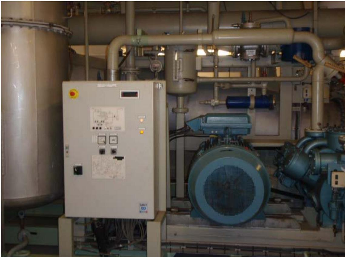
*Figura 67: Generador de gas inerte y aire seco*
