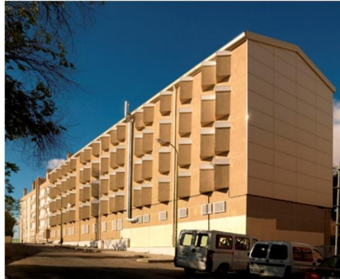
Fig. 4.037- Fachada Este- Rehabilitada
