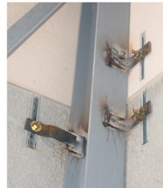
Fig. 4.029- Detalle de los anclajes
