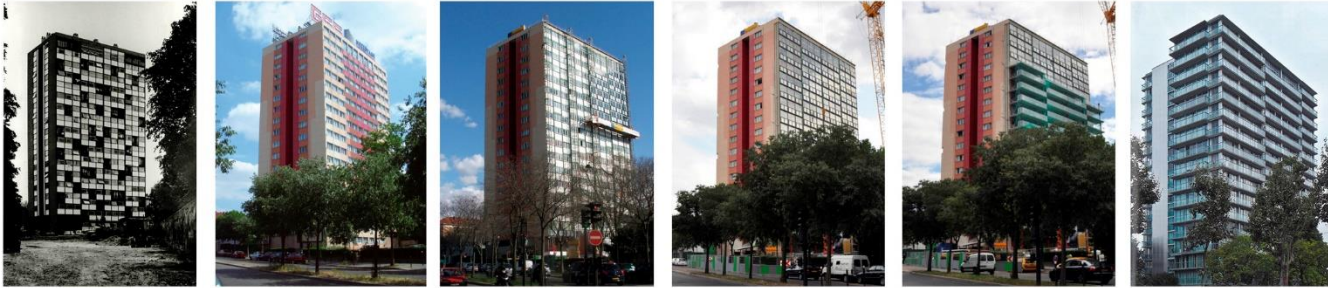
Fig. 4.077- Proceso de transformación de la torre- Original- Rehabilitación de los 80- Rehabilitación actual
