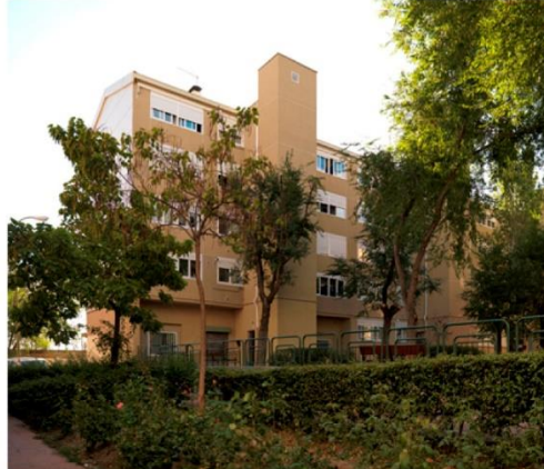
Fig. 4.040- Fachada Oeste- Rehabilitada
