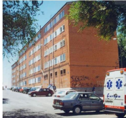
Fig. 4.036- Fachada Este- Original
