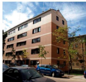
Fig. 4.049- Rehabilitación Fachada Sur
