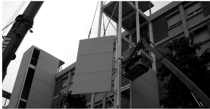
Fig. 4.024- Colocación de los paneles prefabricados de hormigón
