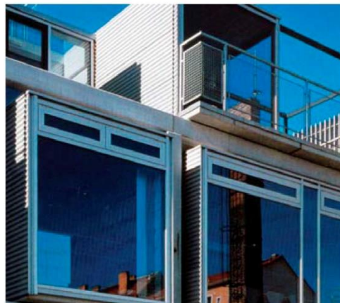
Fig. 4.005- Fachada rehabilitada con módulos prefabri-
