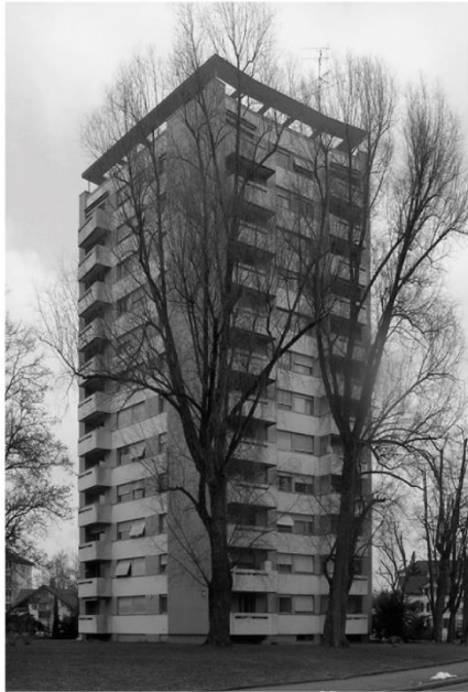
Fig. 4.064- Estado original de la edificación
