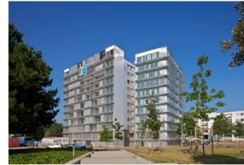
Fig. 4.109- Visión final de la rehabilitación
