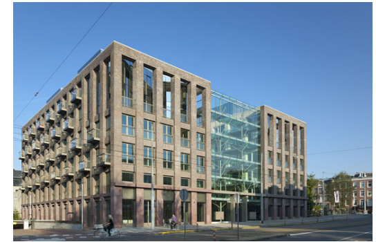
Fig. 2.14- Proyecto Solid II – Vista exterior del edificio
