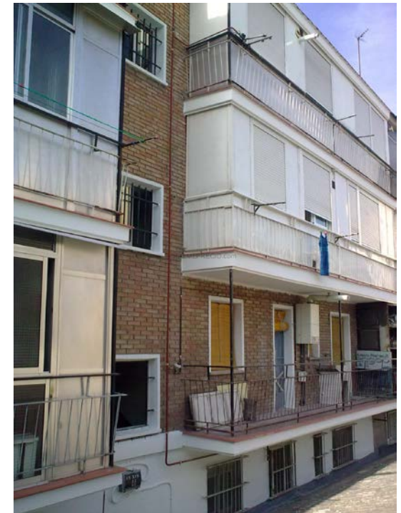
Fig. 3.04 – Cerramiento de balcones en galerías
