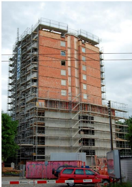
Fig. 4.067- Construcción- nueva fachada- Norte
