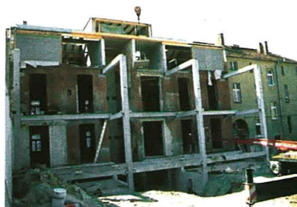
Fig. 4.007- Construcción de la estructura de hormigón prefabricada
