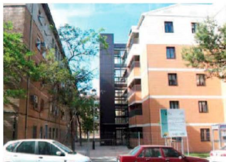
Fig. 4.048-Rehabilitación Fachada Norte- Ascensores
