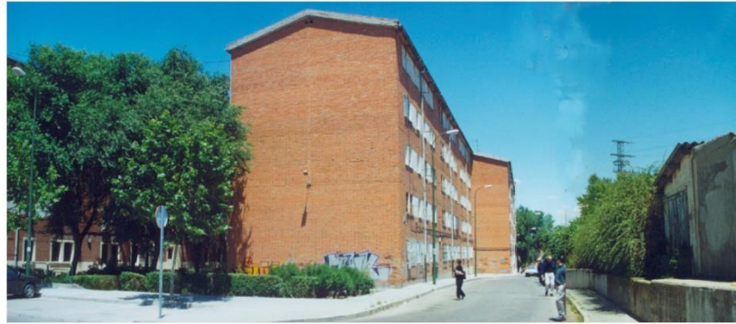
Fig. 4.034-Edificios a rehabilitar- Derribado y rehabilitado
