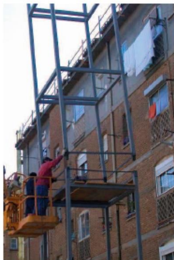
Fig. 4.060- Montaje estruc. ascensor
