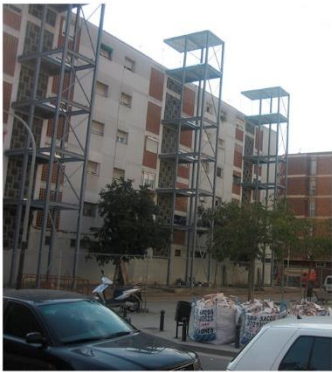
Fig. 4.023- Estr. metálica ascensores
