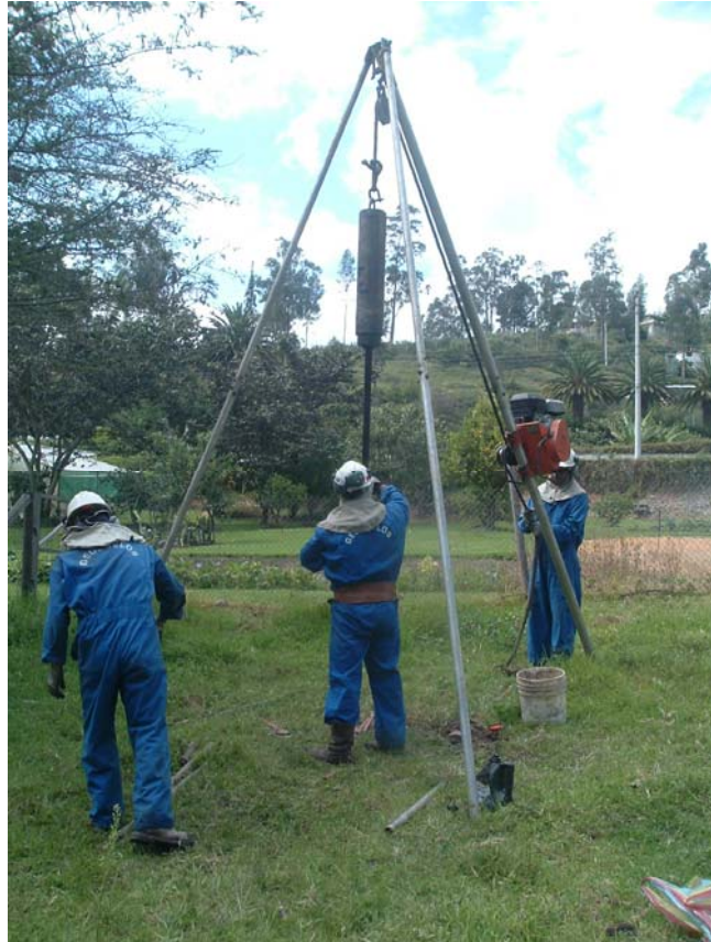
FOTO 1.- Perforación del sondeo P-1.
