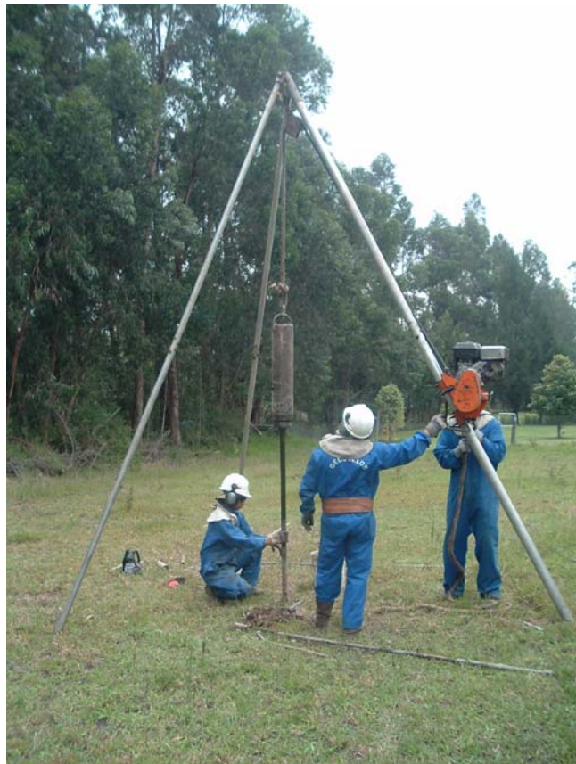
FOTO 2.- Perforación del sondeo P-2.
