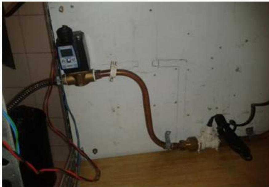
Fig. 9.4. Detall de la vàlvula proporcional i tram d'elevació d'alçada
