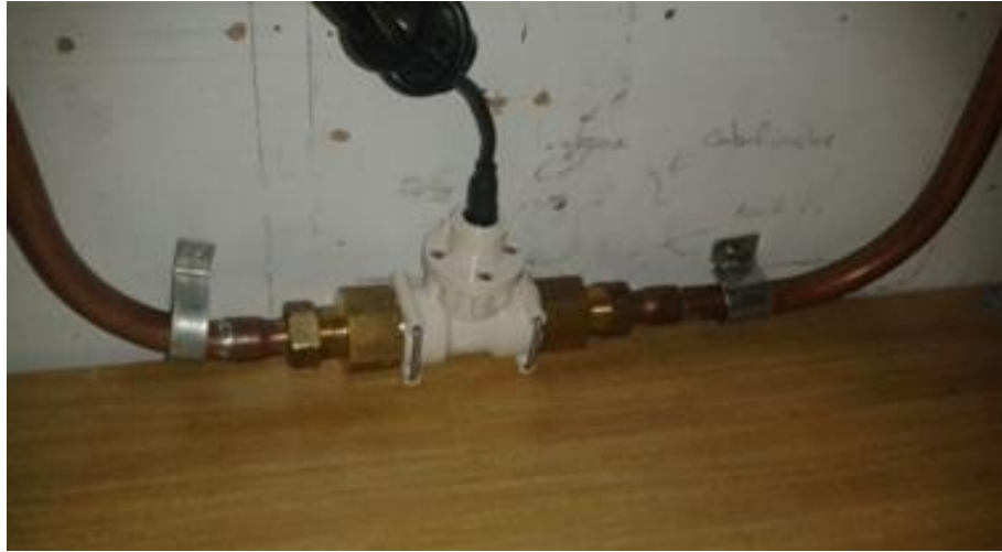
Fig. 9.3. Detall del cabalímetre amb els trams anterior i posterior
