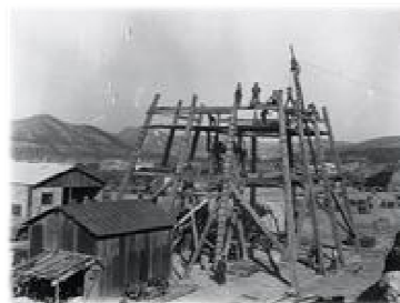
Fig 3. Construcció 1er pou
