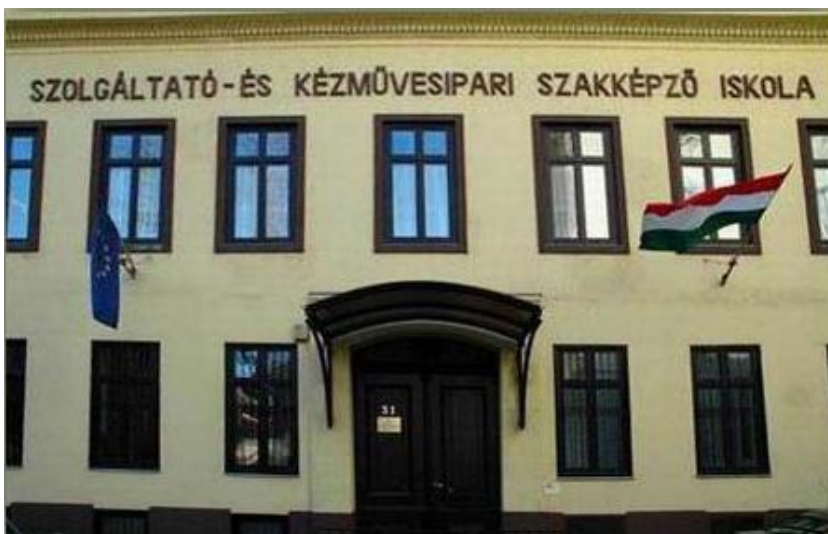
Figura 7.1 Kézművesipari Szakképző Iskola (Hungria).
