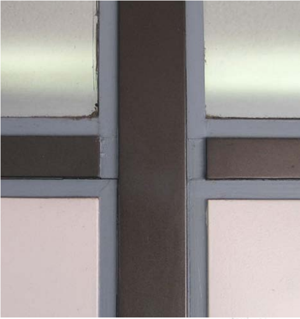
Vista de encuentro de materiales en el tabique Autor: Glenn Deulofeu
