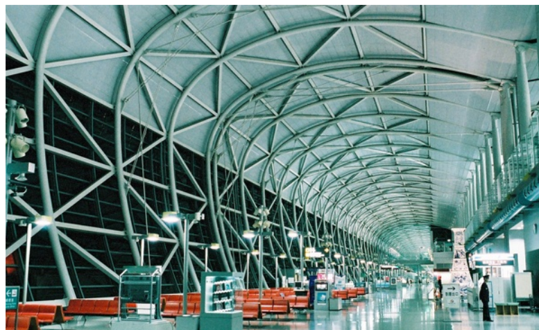
Fig. 41: Zona de embarque. Se puede observar la rigidización del arco a través de tirantes
