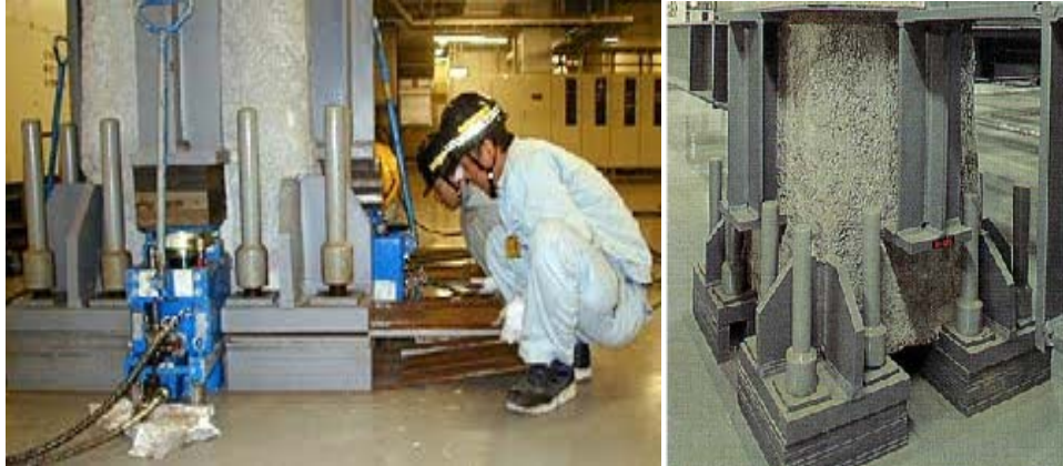
Fig. 34: Sistema Hidráulicos de par corregir el asentamiento que se producen en zonas puntuales del terreno y mantener la horizontalidad de los forjados.
