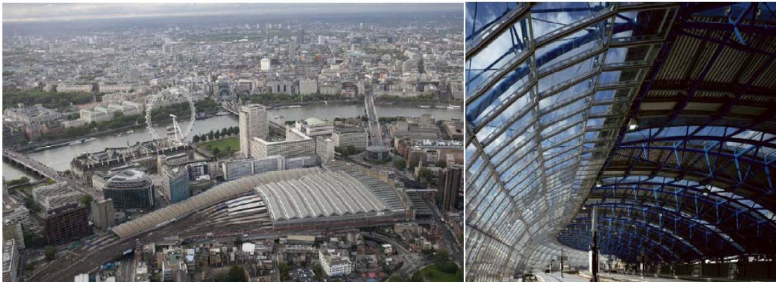
Fig. 21: Vista aérea e interior de la estación de Waterloo
