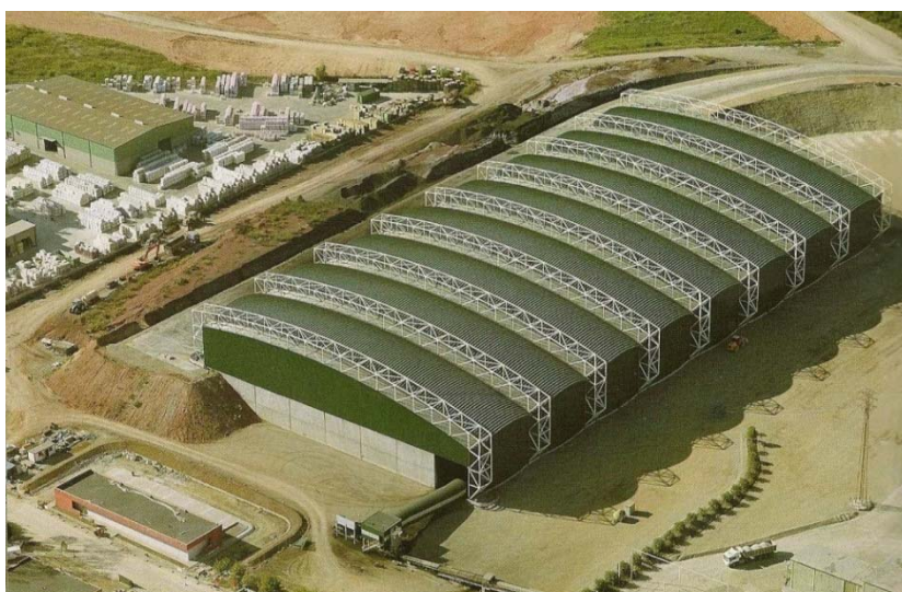
Fig. 24: Vista aérea del almacén de carbón
