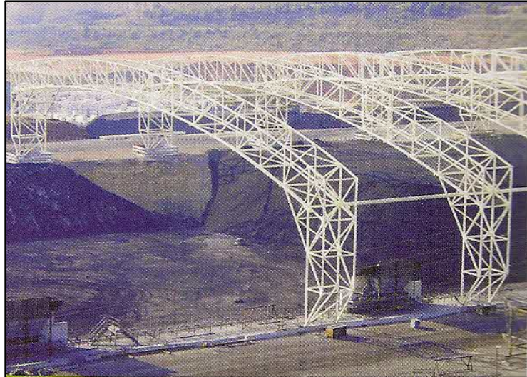
Fig. 25: Proceso constructivo de la nave industrial
