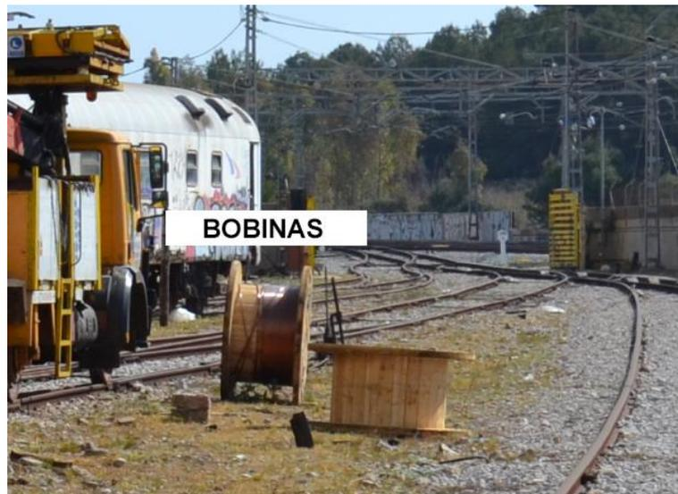
*Figura 79: Bobina de fil de contacte.*
