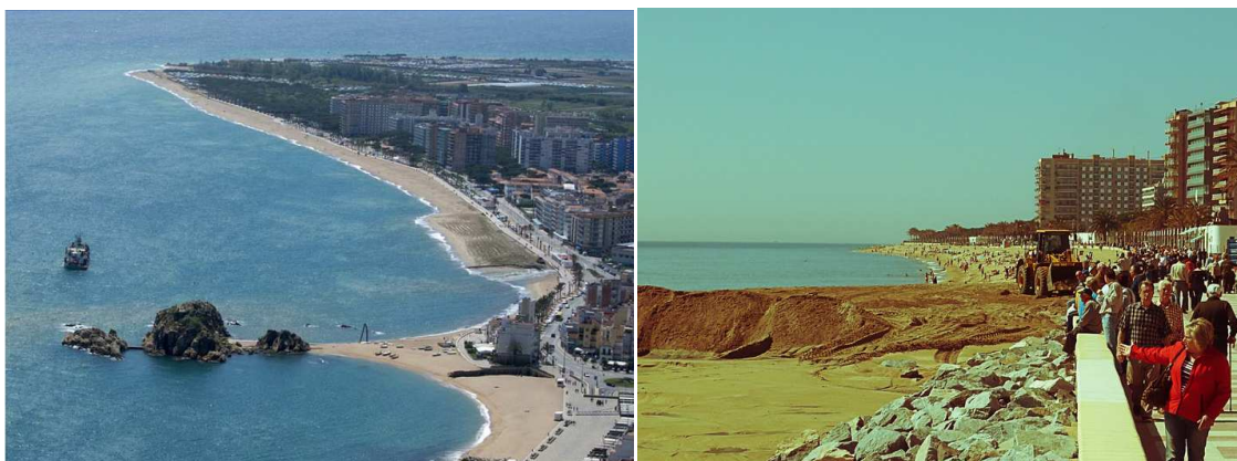
Figura 4.8. Obras de alimentación en la parte norte de s'Abanell (abril de 2008).
