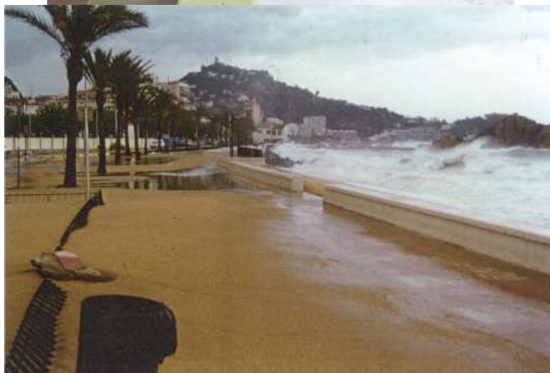
Figura 2.14. Rebase en la parte Norte de la playa de s'Abanell anegando el paseo de arena.
