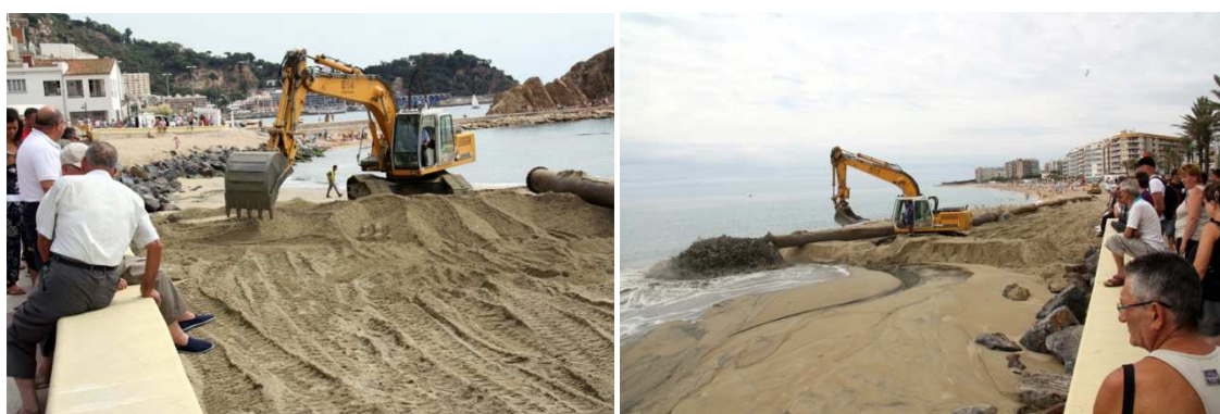
Figura 4.10. Obras de alimentación en la parte norte de s'Abanell (agosto de 2009).
