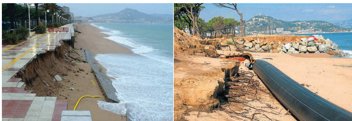
Figura 4.11. Efectos de distintos temporales con roturas en la parte final del paseo (octubre de 2009) y falta de ancho de playa y pérdida de superficie de campings en la parte sur (octubre 2010).
