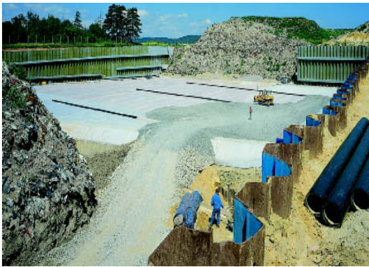
Figura 39: Aplicaciones de tablestacas en control de contaminantes
