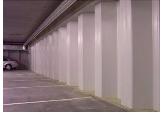
Figura 41: Aplicaciones de tablestacas en excavaciones
