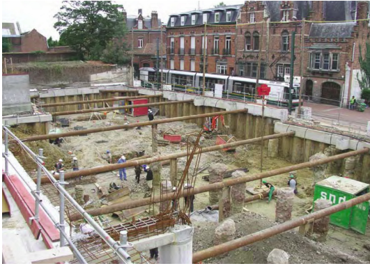
Figura 41: Aplicaciones de tablestacas en excavaciones
