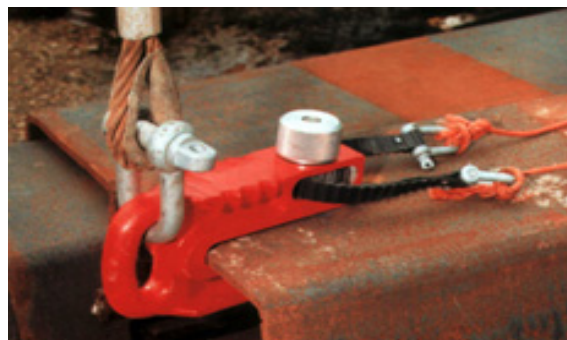
Figura 31: Pinza de izado colocada en la cabeza de la tablestaca
