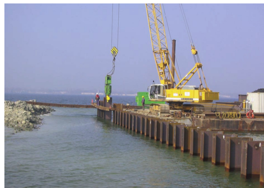
Figura 36: Aplicaciones de tablestacas en puertos
