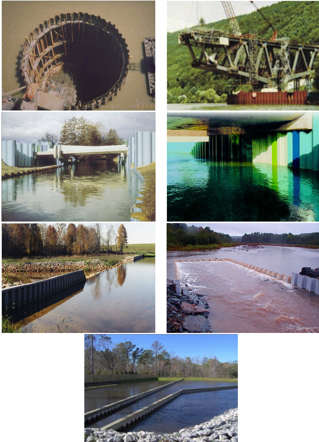
Figura 38: Aplicaciones de tablestacas en estructuras fluviales
