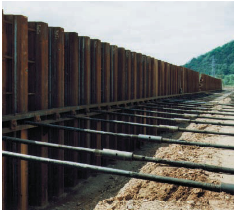
Figura 13. Detalle de uniones de barras de anclaje
