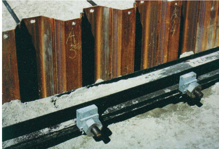
Figura 9: Detalle de viga de reparto
