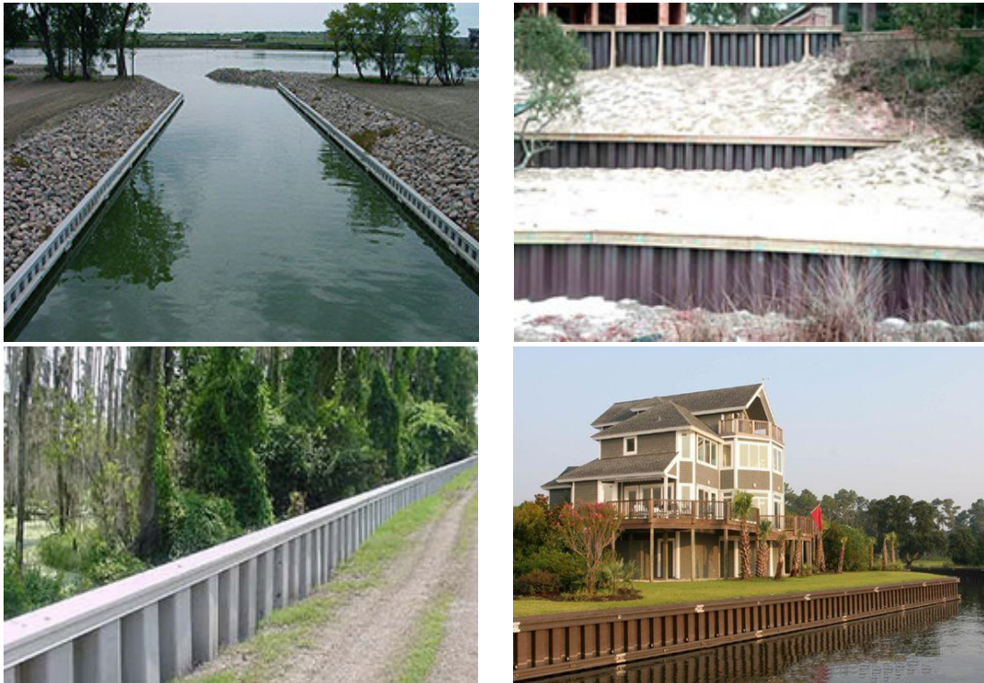
Figura 37: Aplicaciones de tablestacas en ríos
