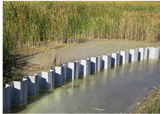
Figura 39: Aplicaciones de tablestacas en control de contaminantes
