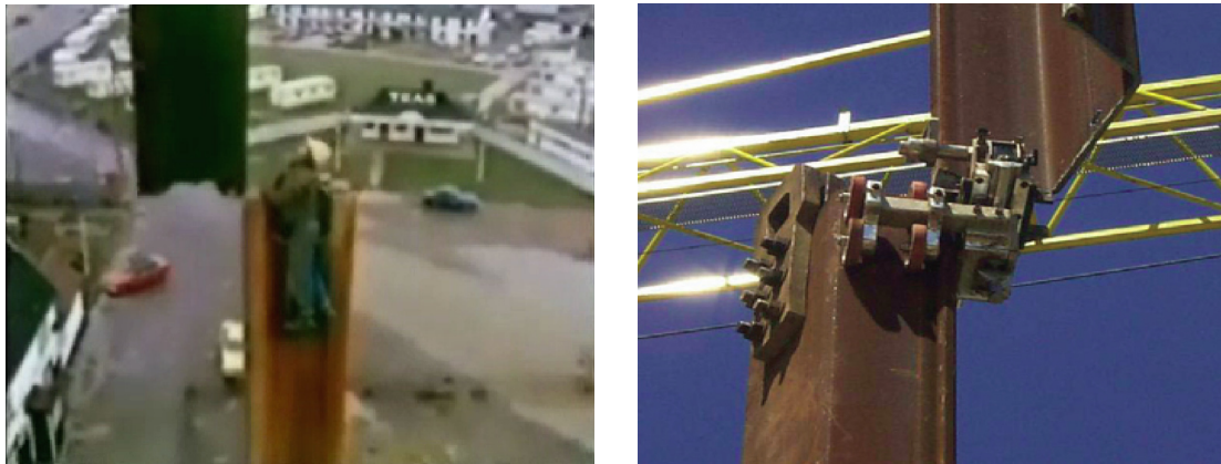
Figura 32: Operación de engarce manual y engarce automático
