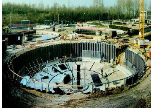
Figura 40: Aplicaciones de tablestacas en tratamiento de aguas
