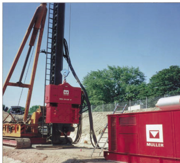
Figura 21: Martillo vibratorio colgado de una grúa de oruga, junto al generador
