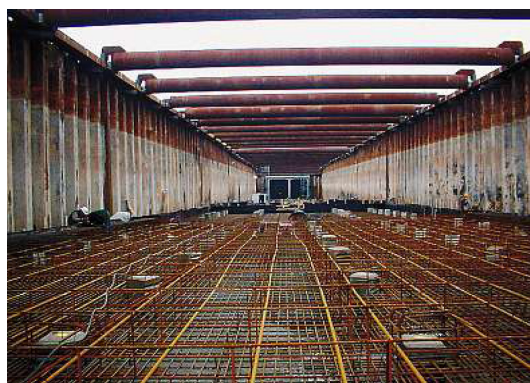
Figura 42: Aplicaciones de tablestacas en infraestructuras del transporte
