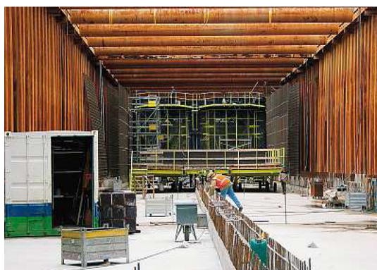
Figura 42: Aplicaciones de tablestacas en infraestructuras del transporte
