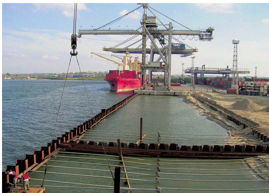
Figura 36: Aplicaciones de tablestacas en puertos
