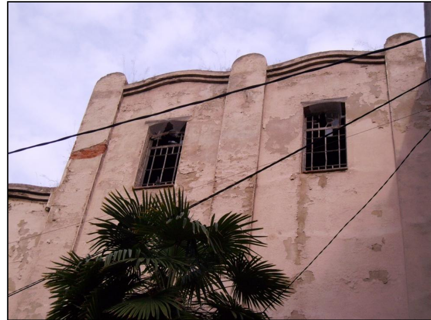
Fotografía de las ventanas de la parte donde estaba situado el escenario del teatro, a la Avenida Libertad.
