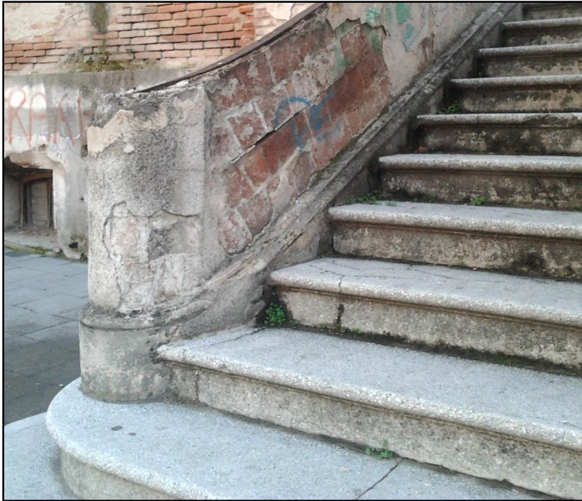
Fotografía de una de las escaleras de entrada al teatro de El Tabaran.
