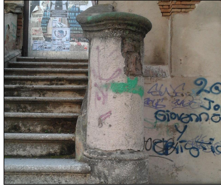
Fotografía de una de las escaleras de entrada al teatro de El Tabaran.
