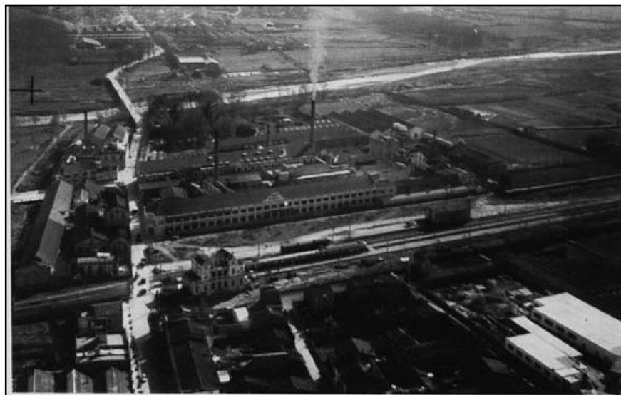
Vista general aérea de la TMFE – año 1962
