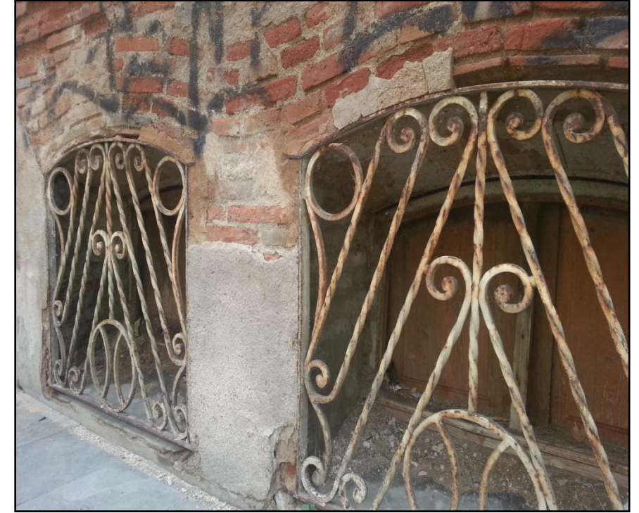
Fotografía de las ventanas de la planta semi-sótano, a la Avenida Libertad.
