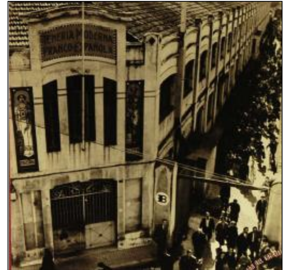
Fachada principal – años 1960
