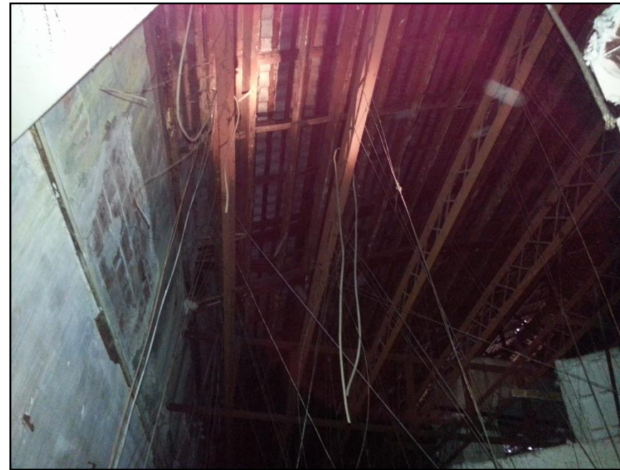
Fotografía del interior del teatro, donde podemos observar las cerchas de madera de la estructura.
