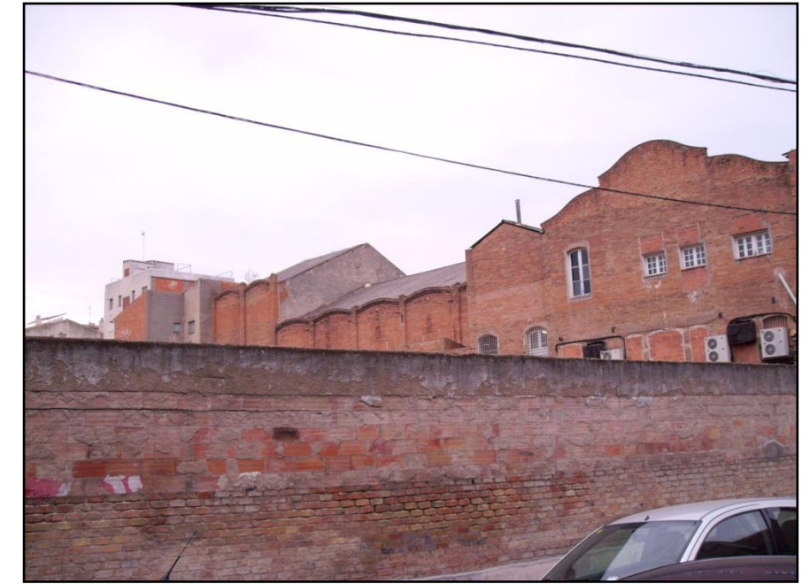
Fotografía de la fachada posterior de El Tabaran, tomada desde la calle Lluís Duran.
